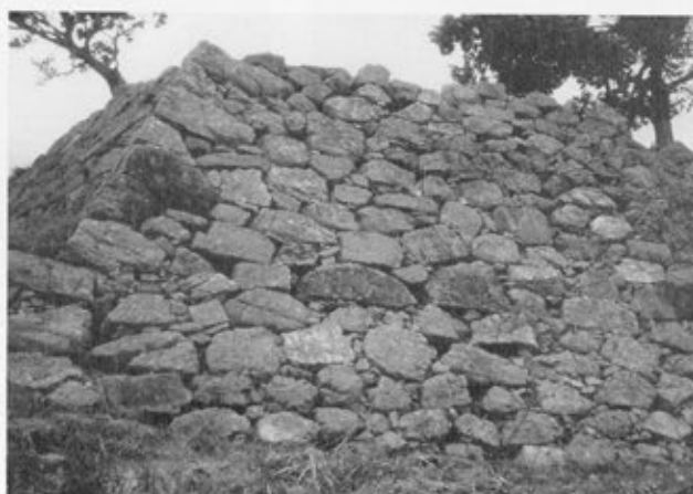
⑦本丸東面東南隅角部
