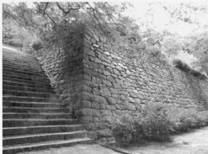
写真30 西山興隆寺石垣（南東より）
