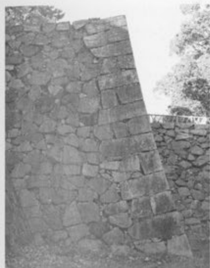
①東二之門橋台南東隅角部(南面)
