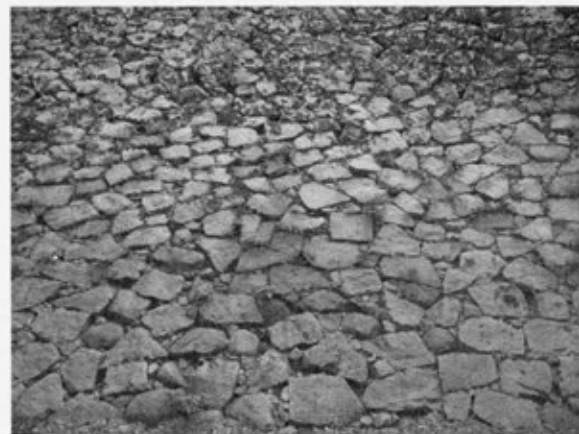
写真6 本丸周辺築石部（北より）
