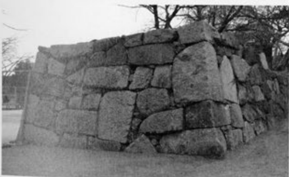
⑤扇坂門石垣（北より）
