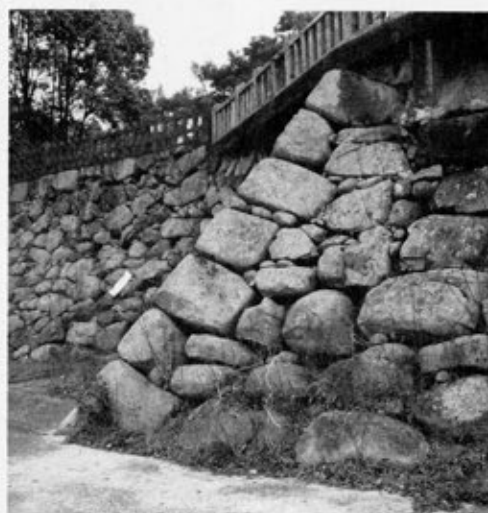
⑤鉄門隅角部（西より）
