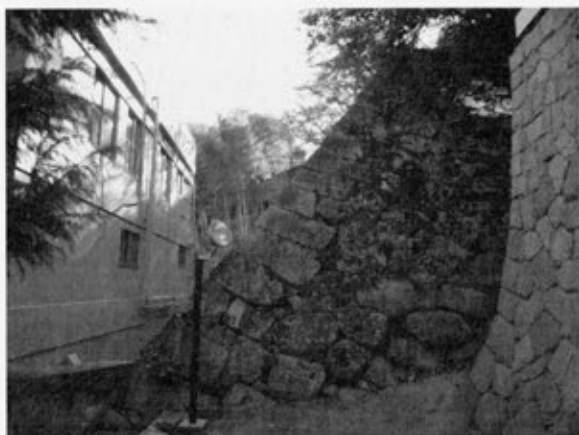
写真3 隅角部（北より）
