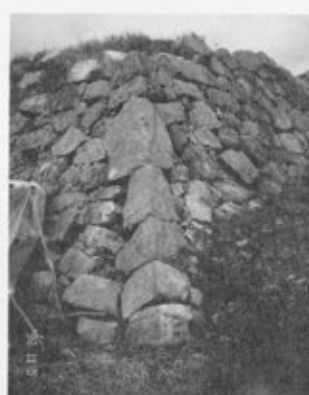
⑤本丸南門虎口隅角部
