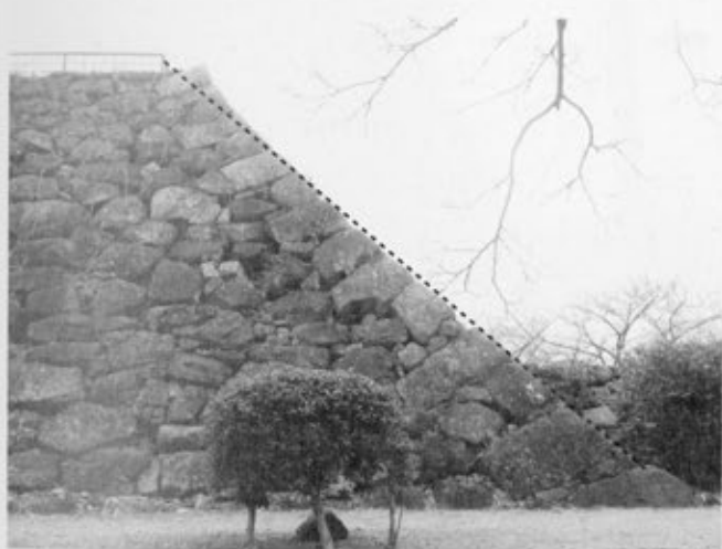
③天守台南東隅角部（南面）
