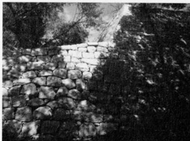
写真17 築石部 (南より)
