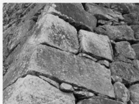
④ 同上③の拡大（南東より）
