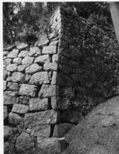
写真14 南登り石垣 (③) 鑄角 (南より)
