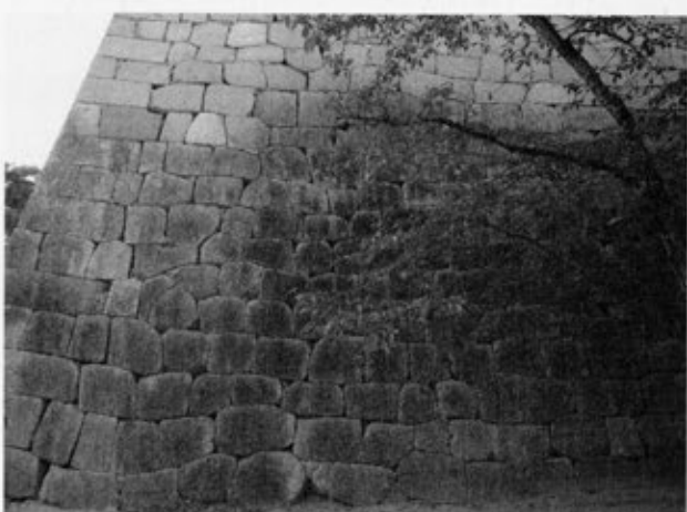
写真19 築石部 (南より)
