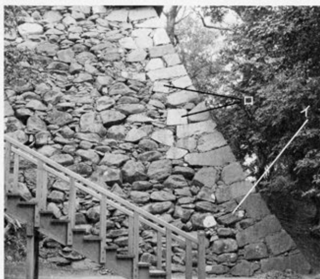
⑥南二の丸南西隅角部（西面）
