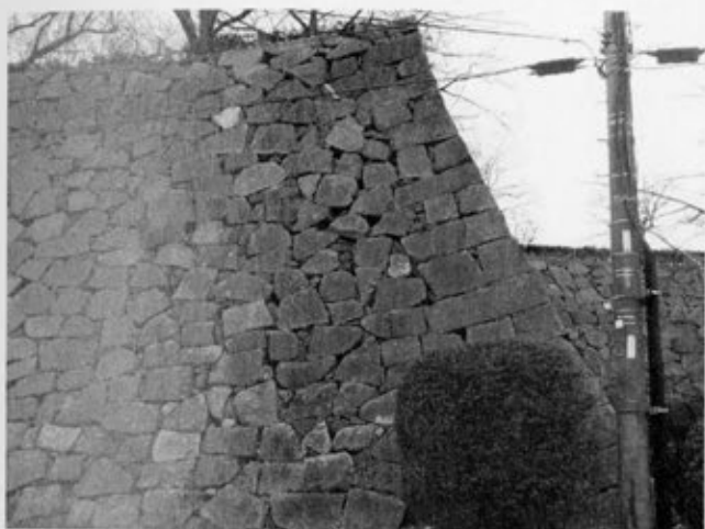
③二の丸松原櫓隅角部（北面）
