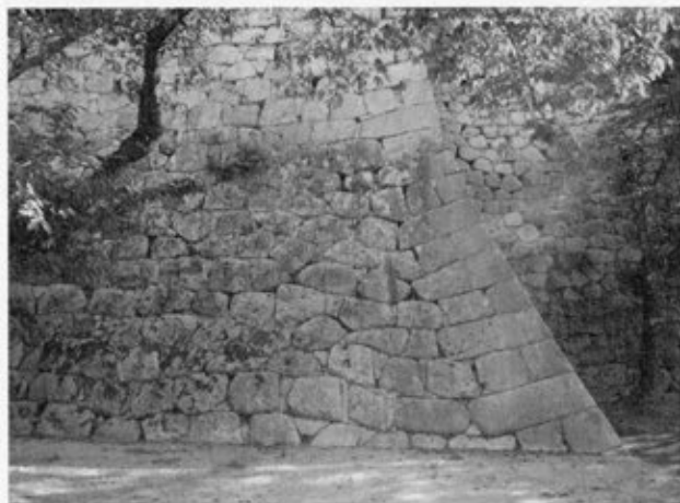
写真11 隅角部 (北より)
