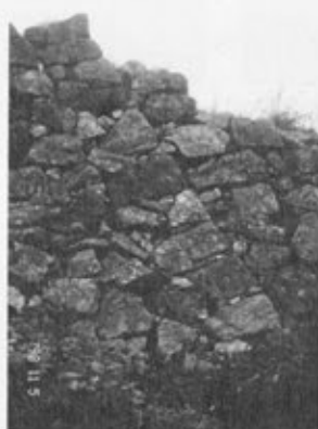
④天守台南西隅角部
