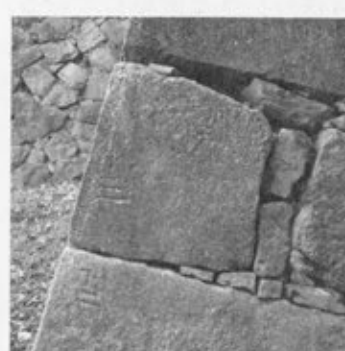
⑥隅角部の表面調整(南東隅角部)
