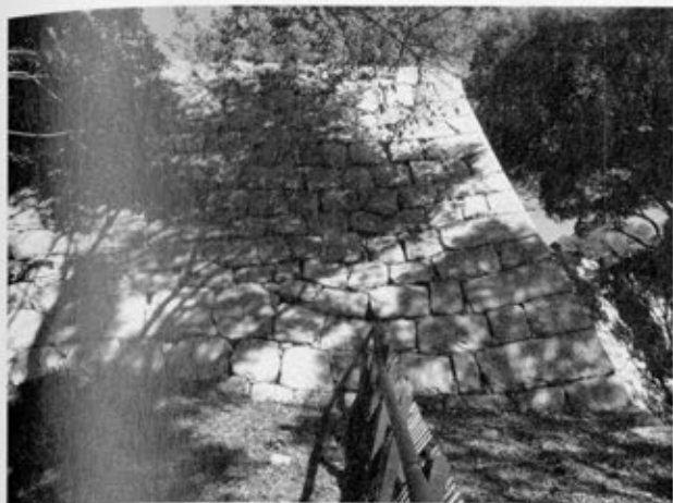
写真16 隅角部 (西より)
