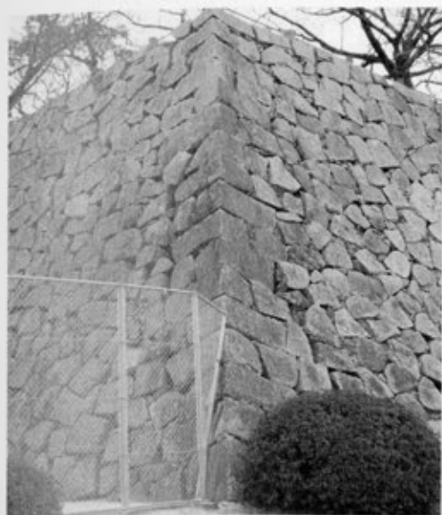
①二の丸萬櫓下隅角部（北東より）
