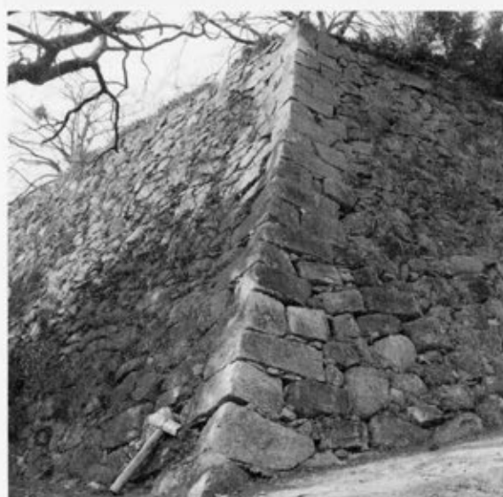
③武具櫓下南東隅角部（南東より）
