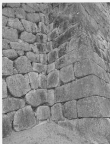
写真29 本壇天神櫓台石垣入角部（南東より）
