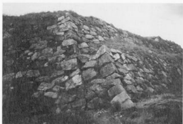
①天守台南西隅角部（西より）
