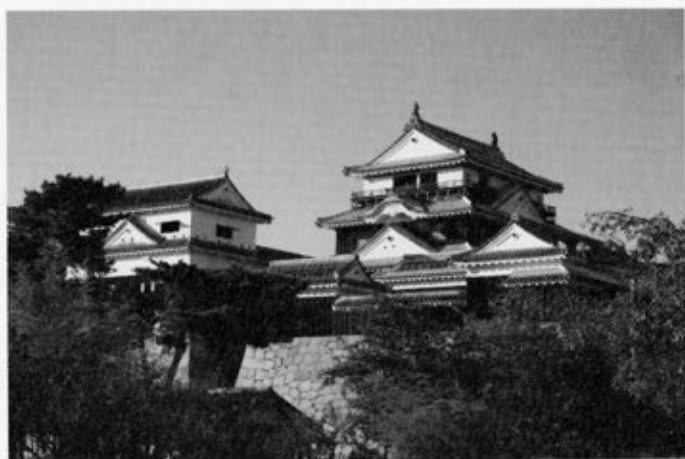
写真1 松山城本壇（南東より）
