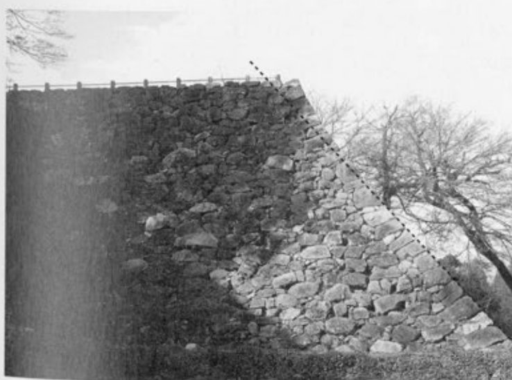
⑤小天守台石垣（南面）
