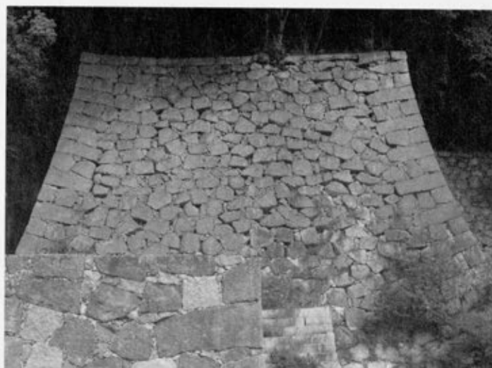
写真8 二之丸周辺築石部（南より） ※手前は現代の改修
