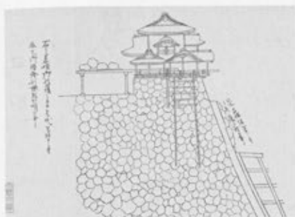
辰巳御櫓台石垣御普請仕形足代等之図 (南から) (大友文庫 金沢市立玉川図書館所蔵)
