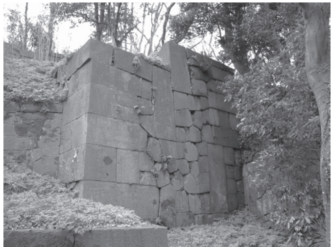
写真5 玉泉院丸庭園向きの石垣
