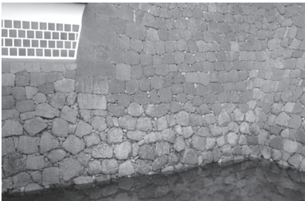
写真1. 橋爪門続櫓北面・五十間長屋東面石垣
