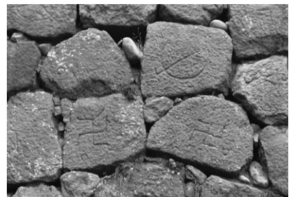
V類石垣 三ノ丸白鳥堀縁
