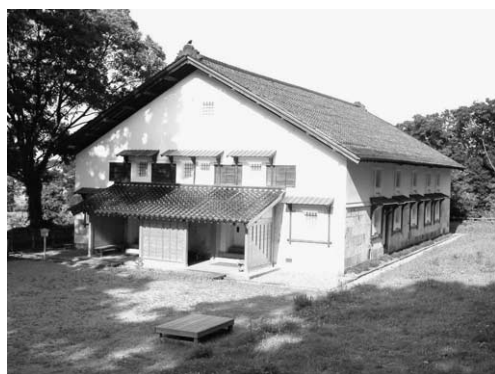
写真1 現況の鶴丸倉庫
