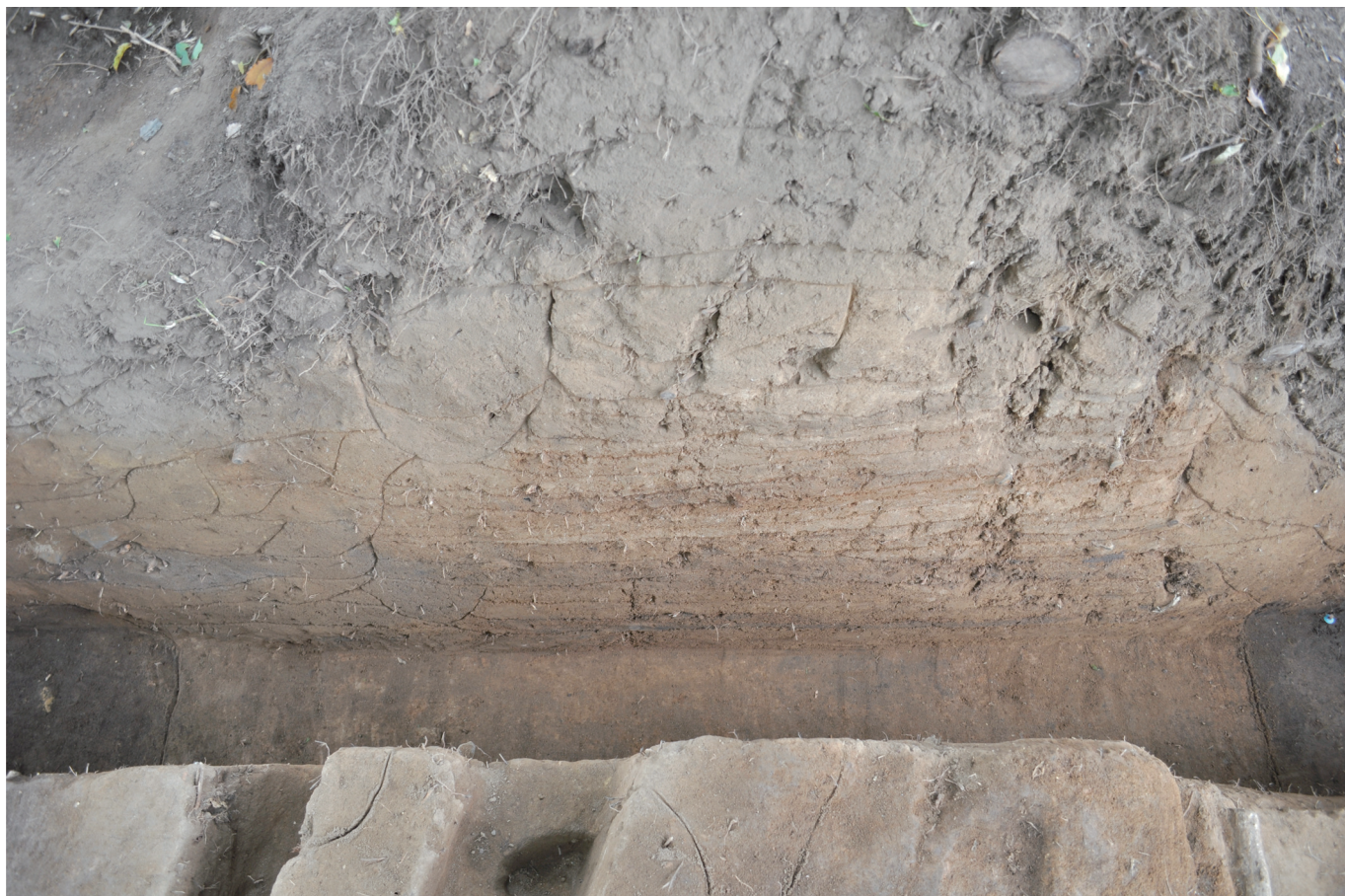
①SF2300築地塀跡土層断面(105次A区、東から)
