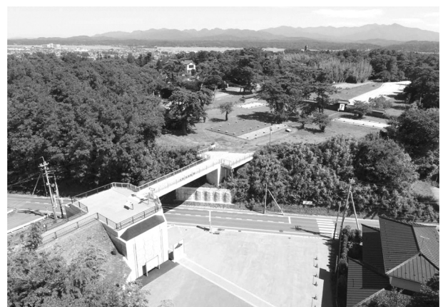
史跡公園連絡橋（南西から）
