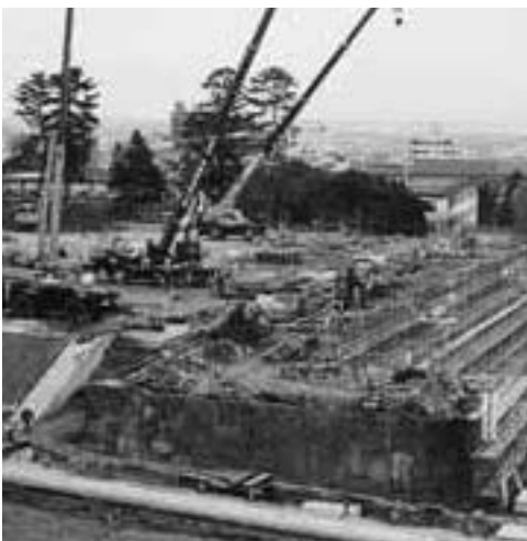
写真3 菱櫓・五十間長屋・橋爪門続櫓台の石垣解体調査風景
