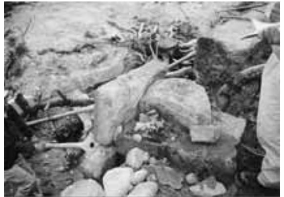
写真25 パネル石による修理
