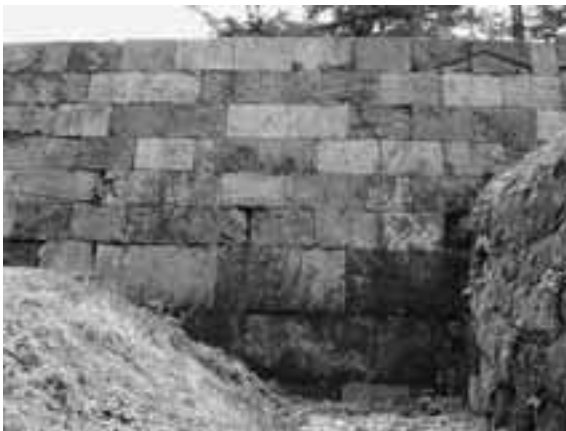
写真8 二ノ丸数寄屋敷 上半はII類 下半はIa類 (I期に再調整)
