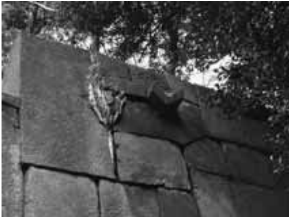
写真14 滝つぼ石垣の石樋(黒色の坪野石)
