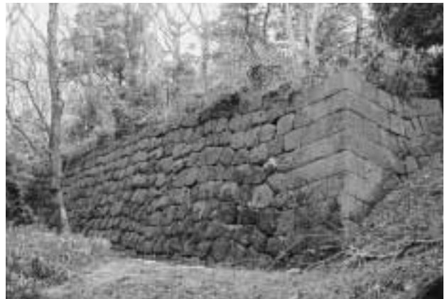
22 薪ノ丸北石垣 寛文6年修築。
