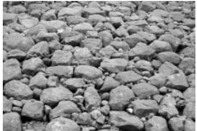
4 本丸東高石垣・築石部
