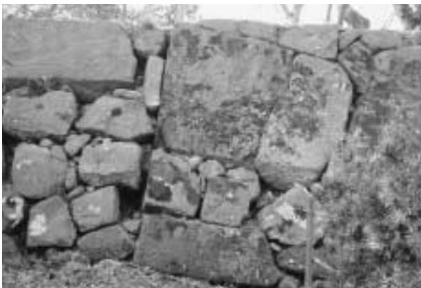
7 新丸尾坂門隅角部埋め殺し
