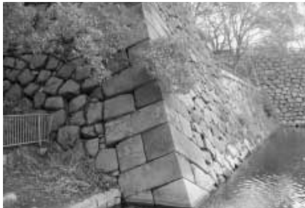
29 大坂城青屋口北西角石垣
