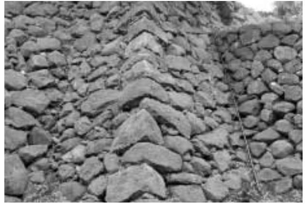
2 本丸丑寅櫓下東面石垣・隅角部
