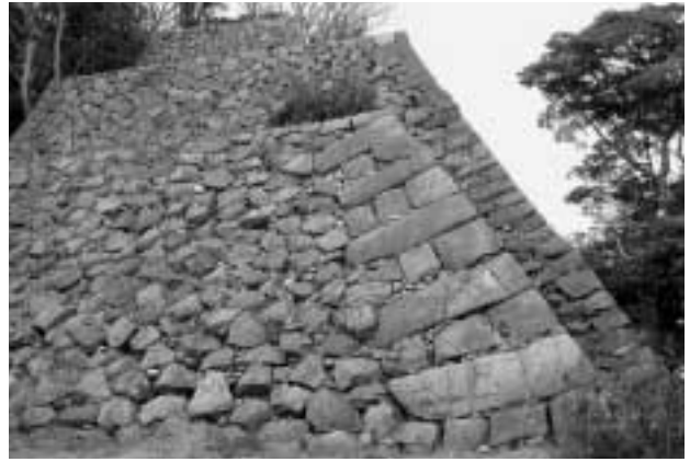
10 本丸南高石垣(辰巳櫓下)・隅角部
