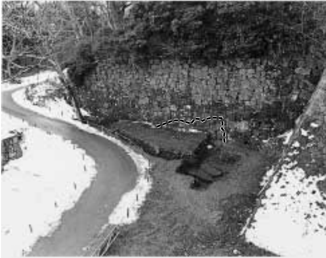
写真1 東ノ丸唐門前調査区全景 (破線は埋めこまれた部分)
