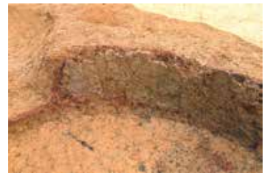
SL1 壁面硬化状況（南から）
