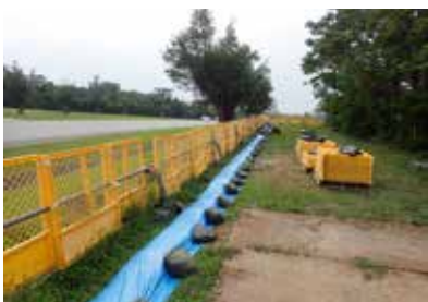
現場安全及び赤土流出対策状況
