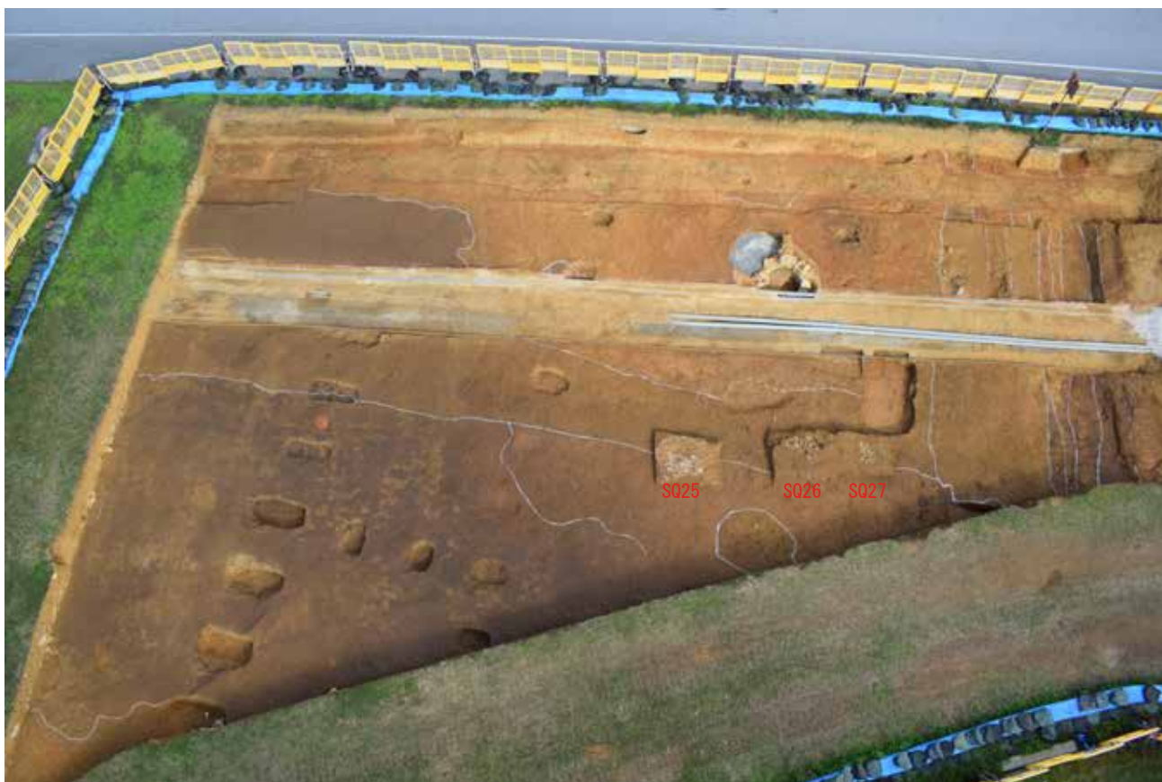
第4遺構面の検出状況（南から）
