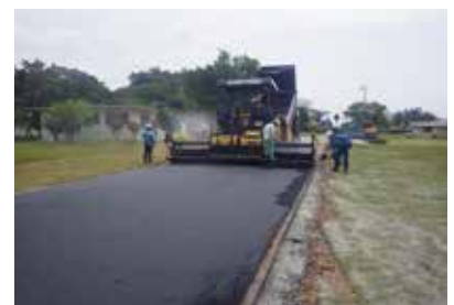
道路アスファルト復旧作業
