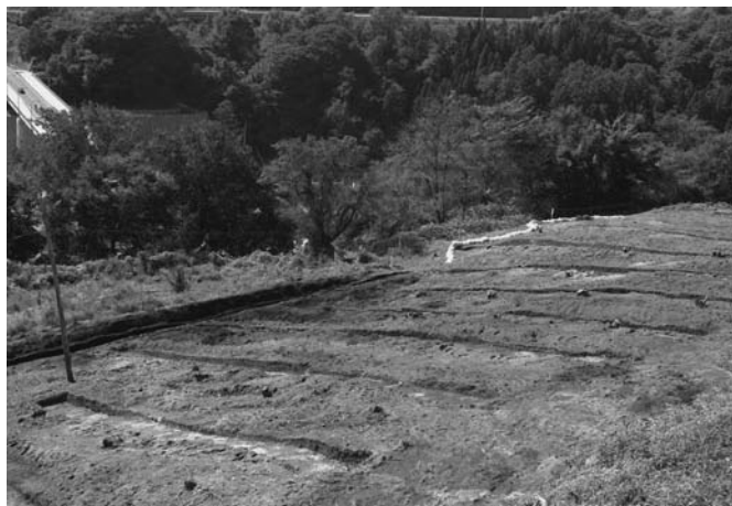
18区トレンチ全景(北東より)
