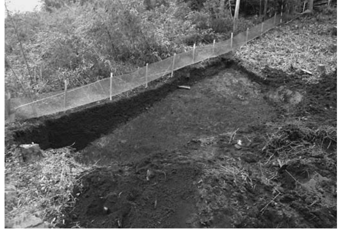
第1トレンチ全景(東より)
