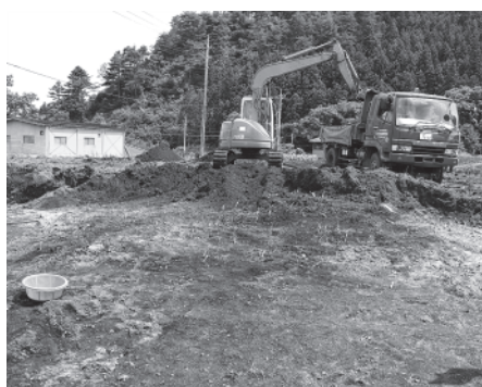
13. 表土掘削(北から)
