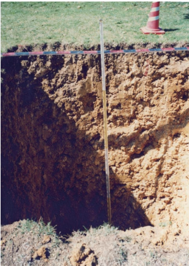
試掘 No. 3 南壁
