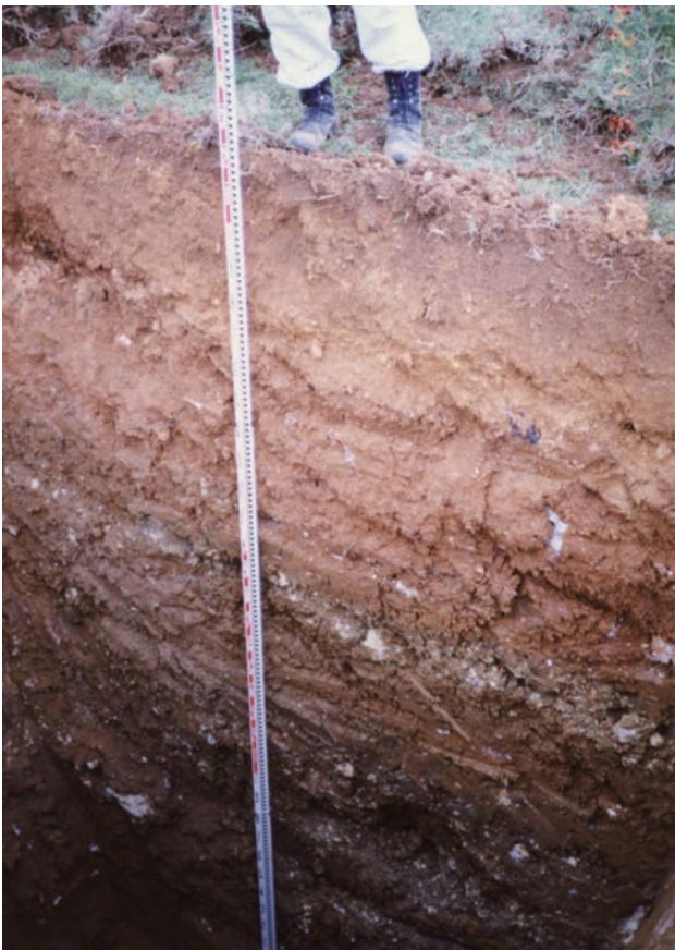
試掘 No. 12 上層
