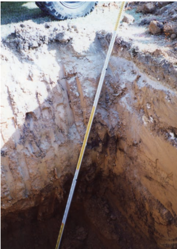
試掘 No. 2 上層
