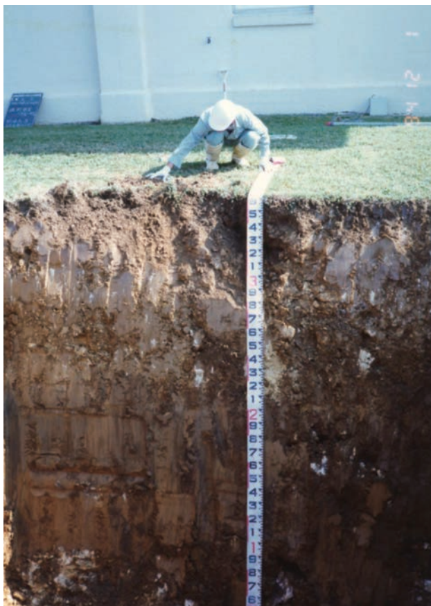
試掘 No. 2 上層
