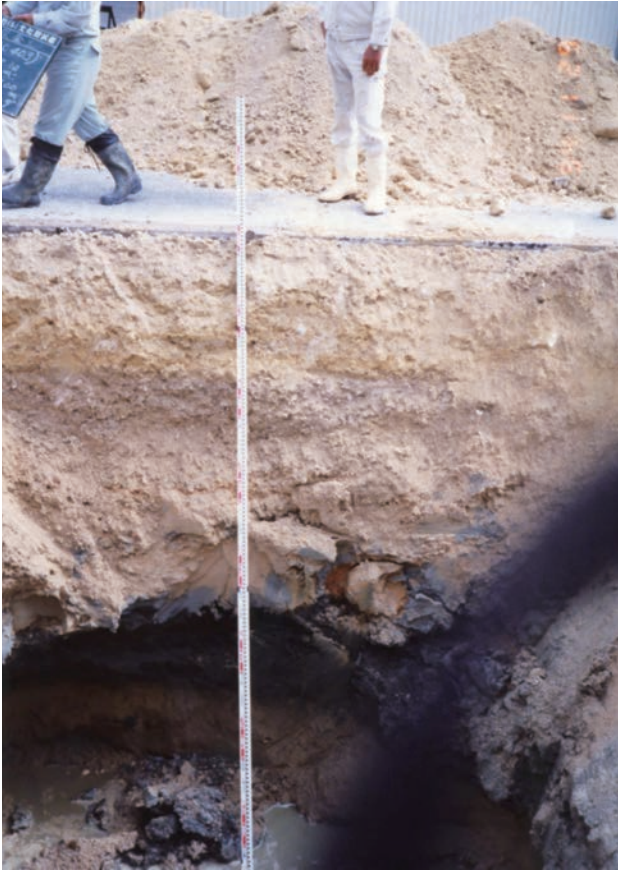
試掘 No. 3 上層
