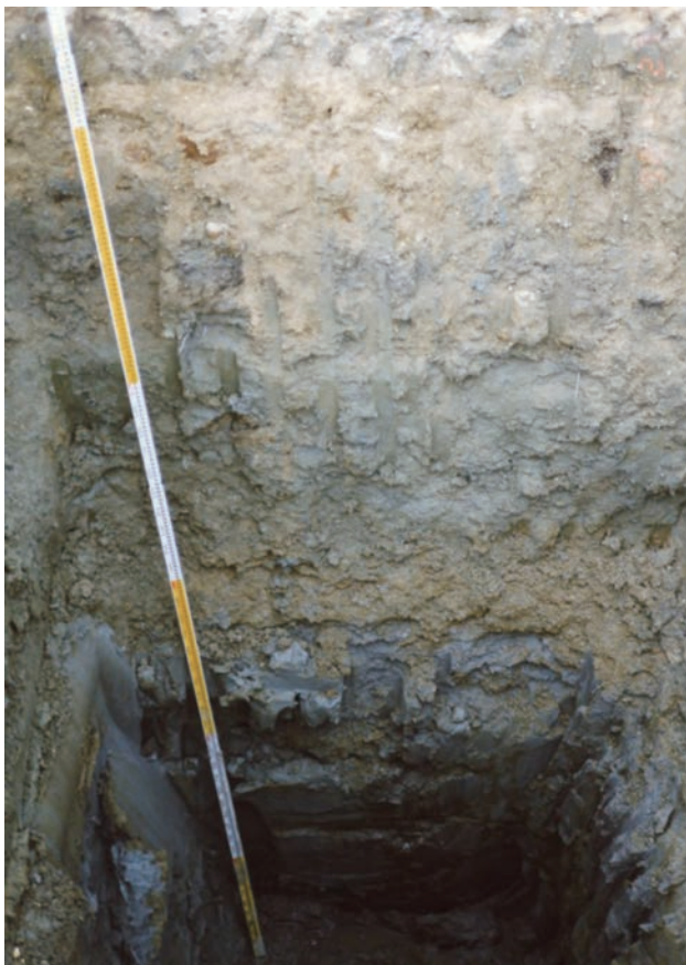
試掘 No. 1 上層
