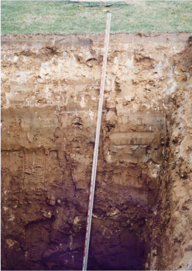
試掘 No. 1 上層
