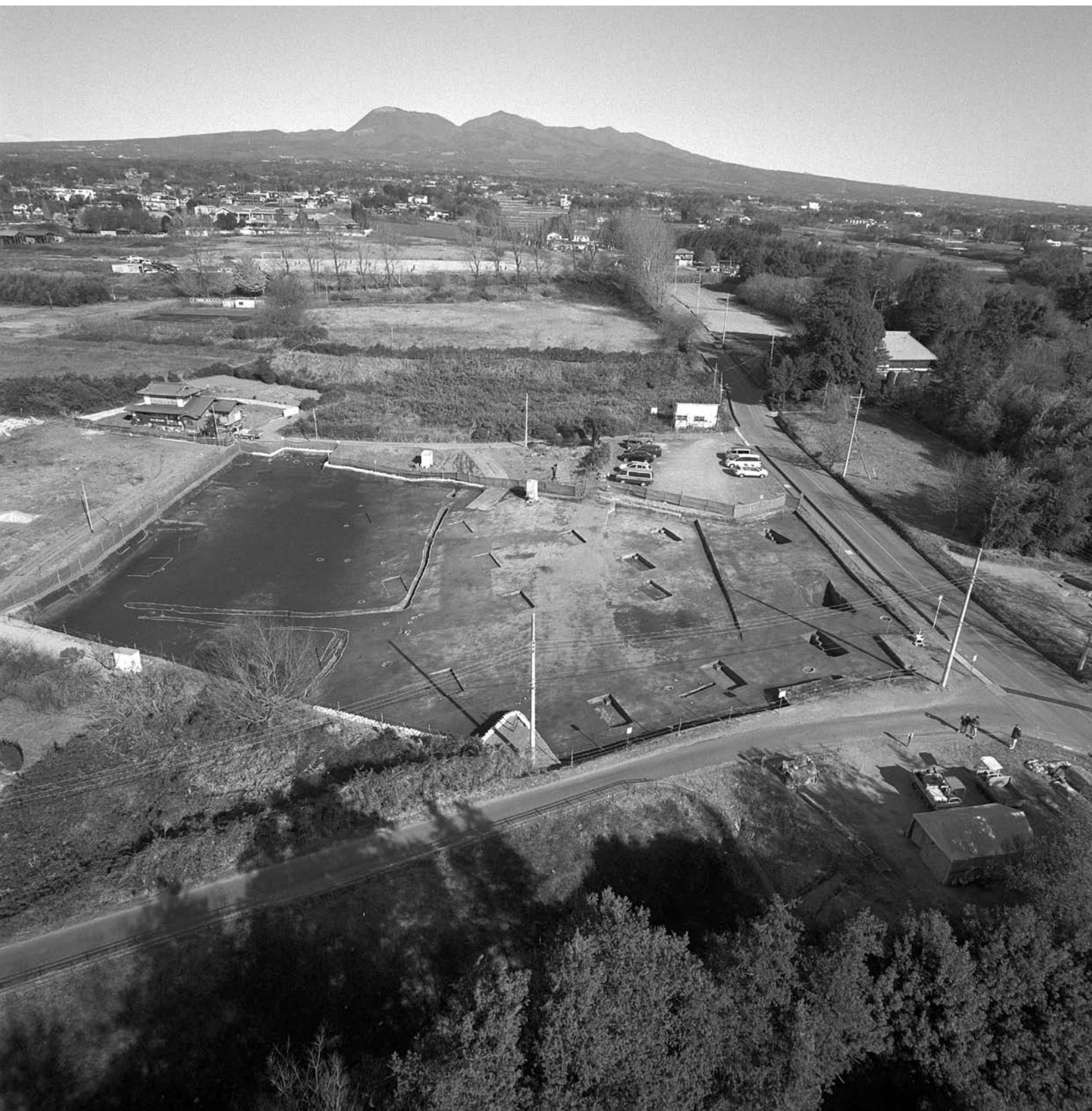
IV区全景 南上空から
