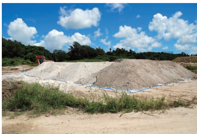
作業ヤードに積まれた改良中の土壌
