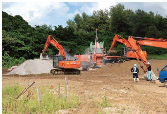
石灰を混ぜての土壌改良作業
