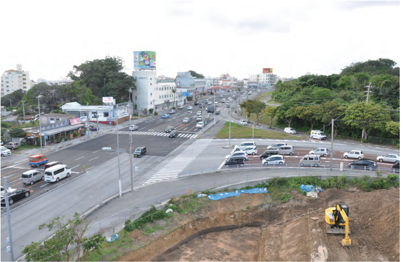
調査区遠景（北側を望む）
