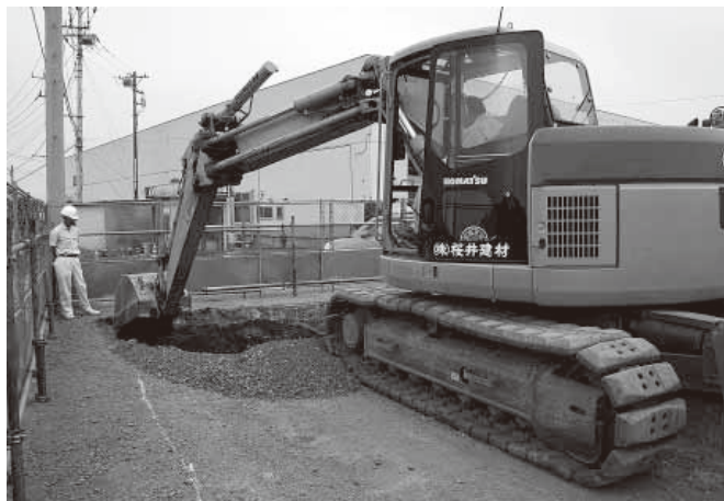
2 重機による表土の掘削
