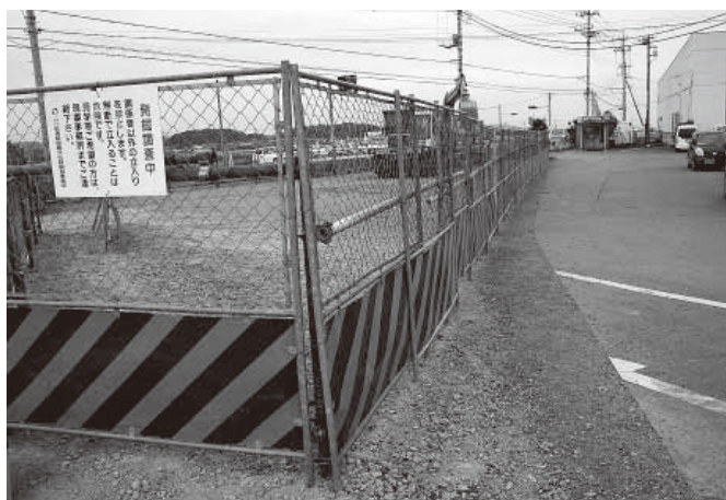
3 通行路に安全フェンスを設置
