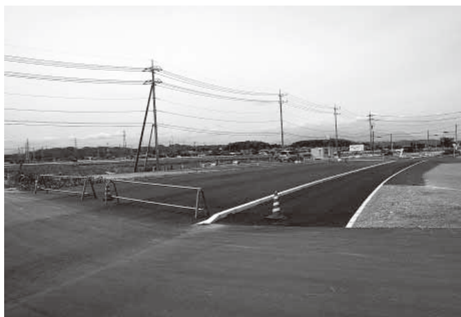
6 道路建設が進む調査地
