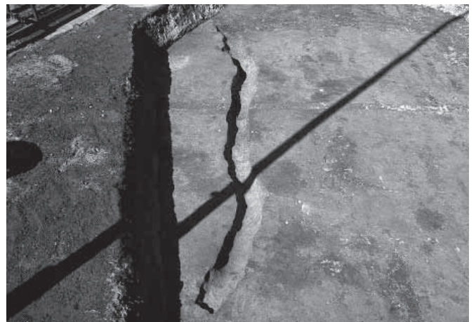
6. 1区3号溝全景(南東から)
