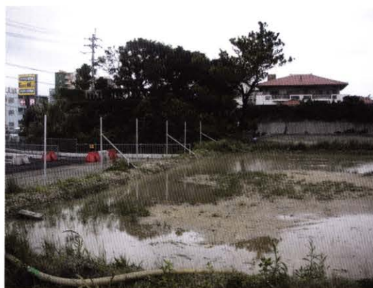
着手前状況（樹木部分がクランモー）
