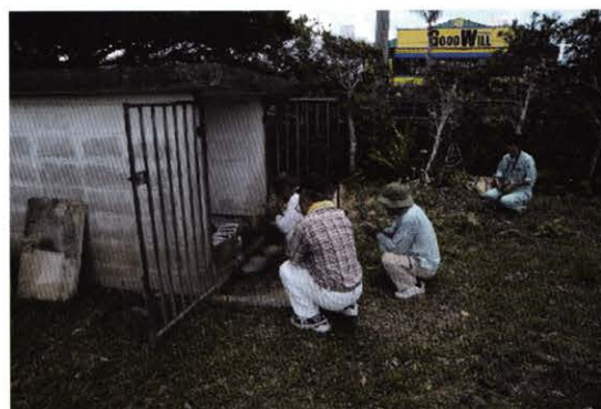
井戸移転状況
