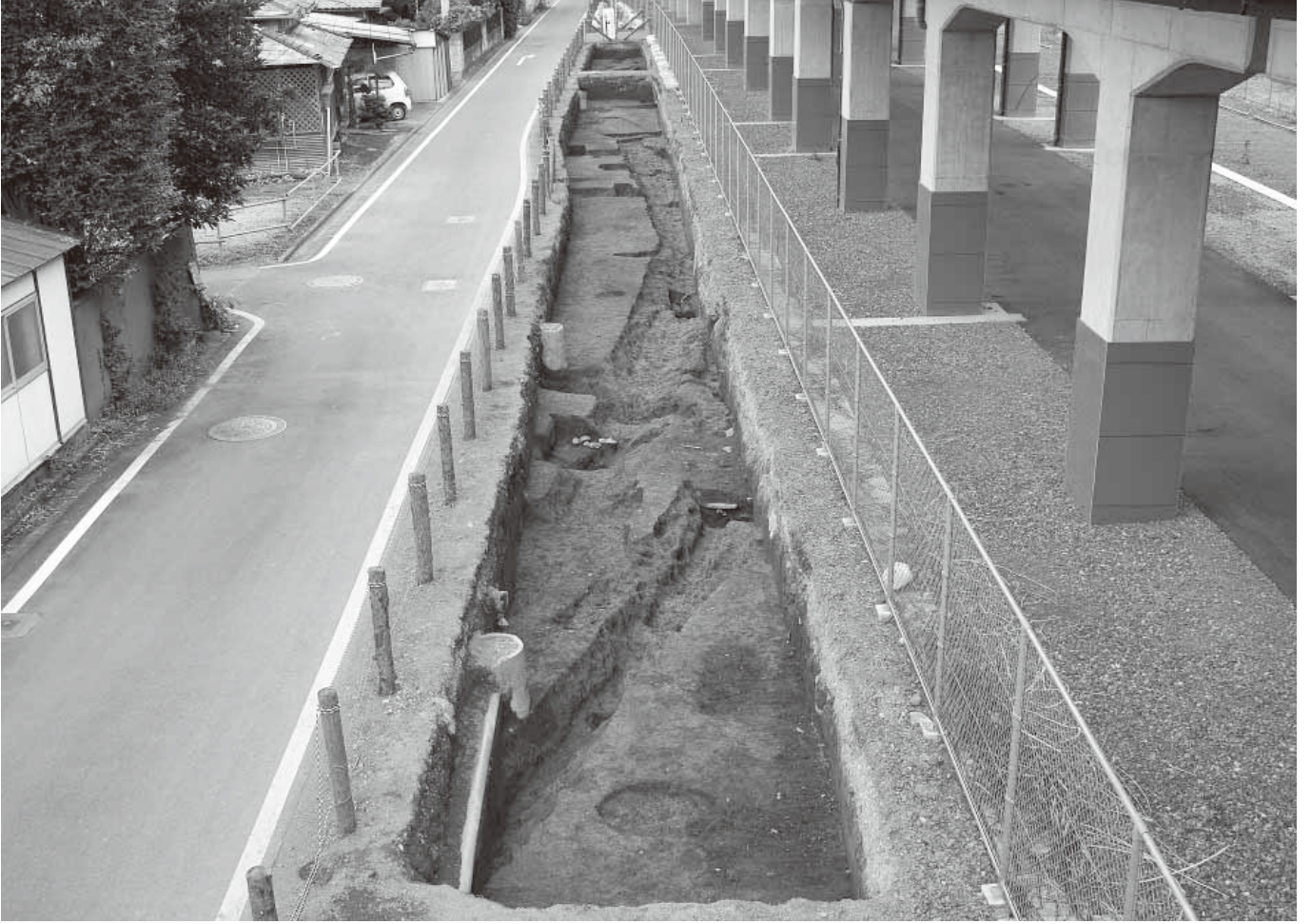
浜町古墳群 3区全景(東から)
