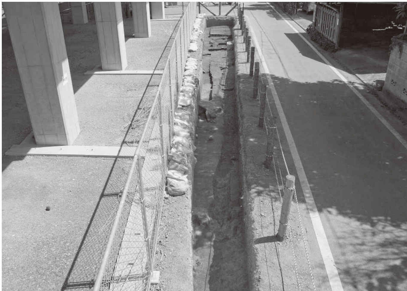
浜町古墳群 1区全景(西から)
