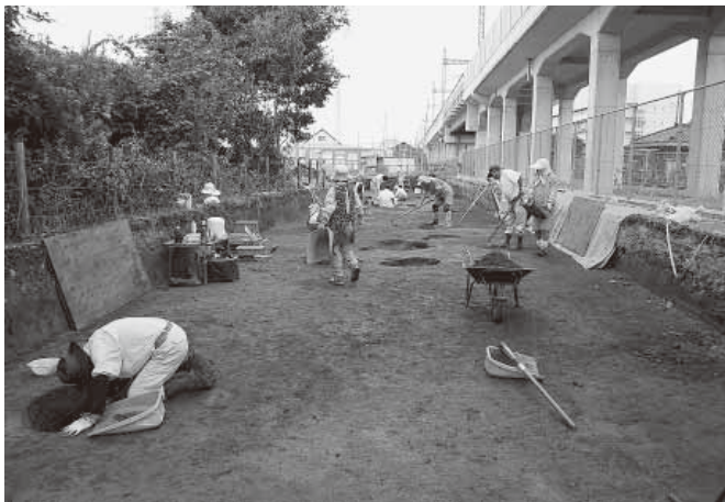
3 7区調査状況(東から)
