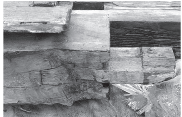
写真1 土台継手部分。雇い鎌柄を使った継手。正面は底面で、礎石の面にひかり付けのための欠き込みがある。写真上面は土間内部側となり、大戸等の建具の敷居の役割をする付け樋端がついている。また、胴付きミゾがあることから、この材は女木である。
