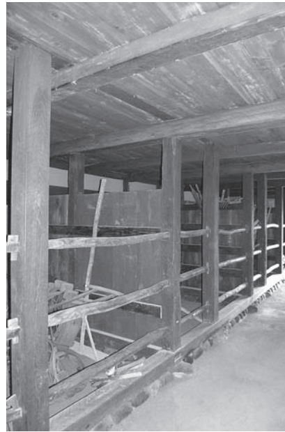
写真3 旧富沢家馬屋 厩栓棒を入れる柱及び間仕切りの柱には、土台が入れている。
