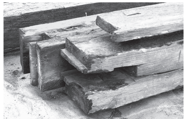
写真2 土台継手部分。雇い柄を使った継手。写真正面は上面となる。写真上面は土間内部側となり、付け樋端がついている。木口には胴付きが刻まれていることから、この材は男木である。
