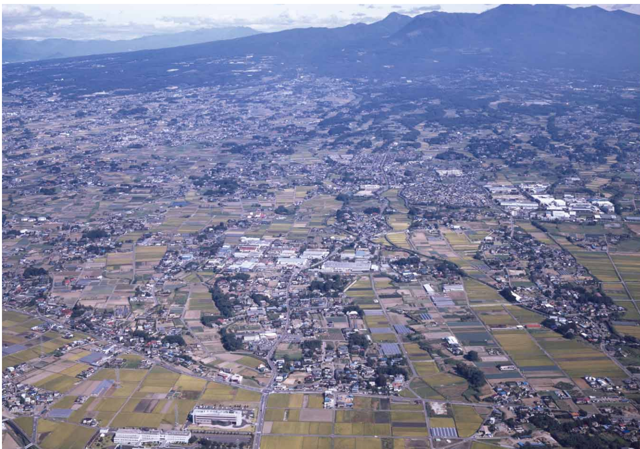
上武道路（8—2工区）予定路線地 西側（前橋市北部：南から）
