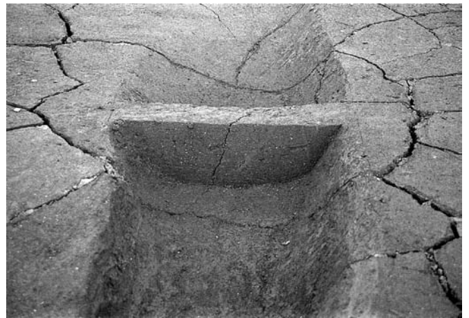
4 21号溝断面 A-A' (南西から)
