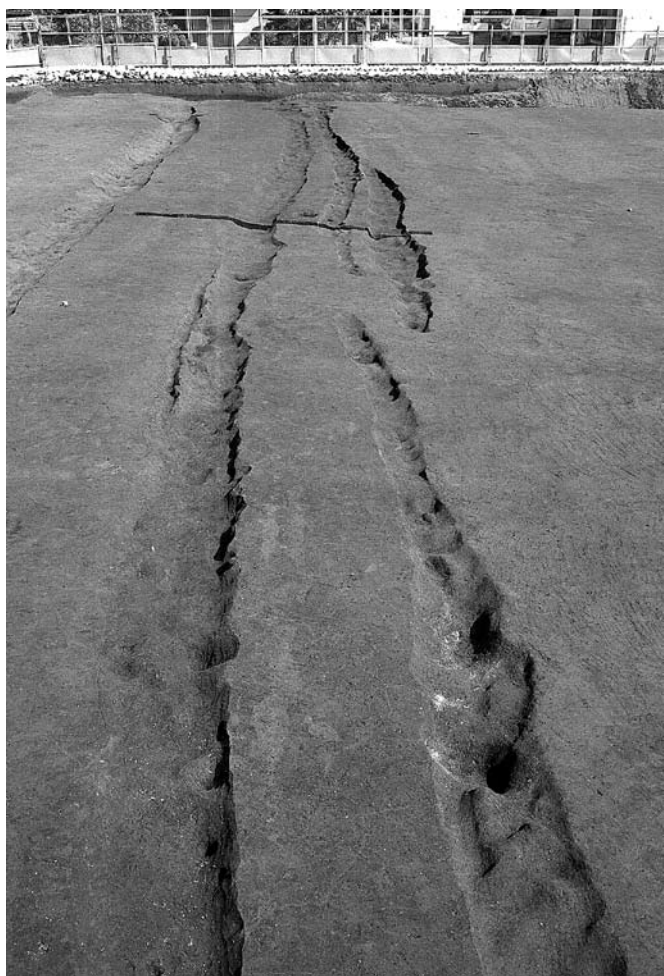
3 5～7号溝全景（北西から）
