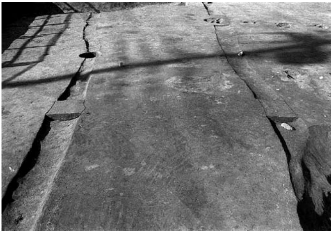
2 1号道路状遺構断面A-A'（南東から）
