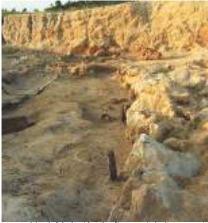
基地接收後造成面（南側より）
