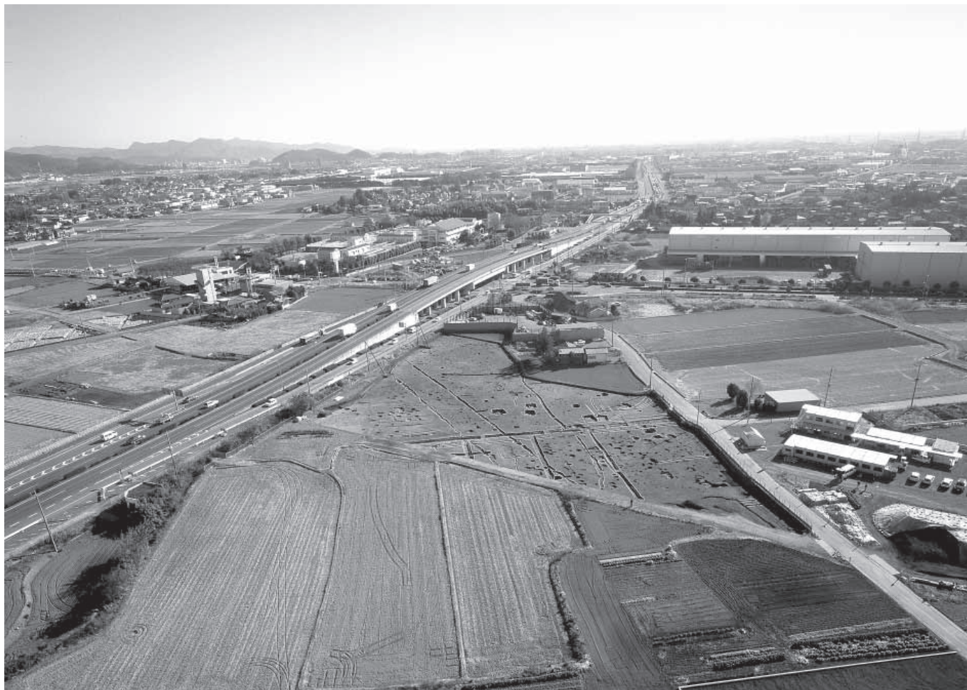
1. 1区全景(西上空から)
