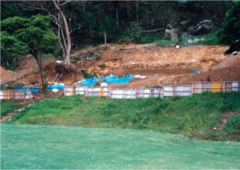
no.3・4トレンチ(C・D-3・4) 遠景
