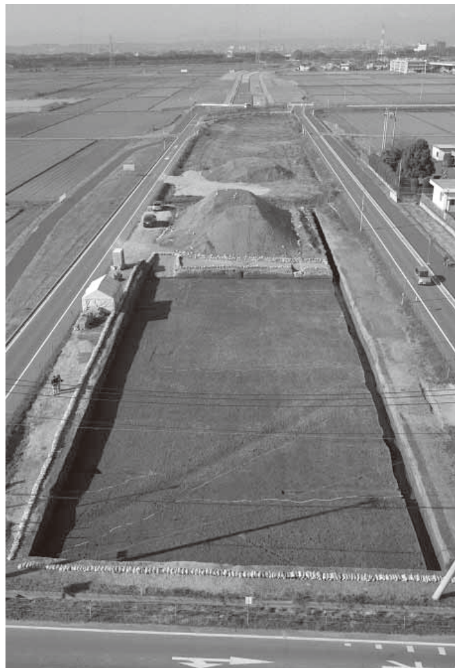
2. Ⅱ区浅間Bテフラ直下水田全景(中央区/東上空から)
