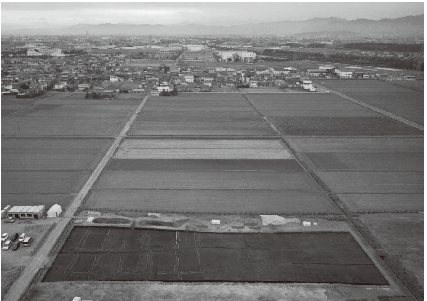
2. Ⅷ区中近世面全景(北から)
