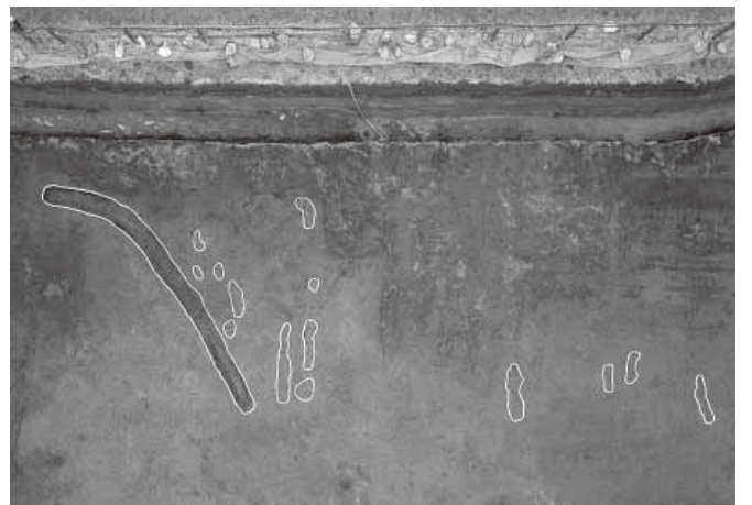
5. IV区3号復旧溝群全景(南から)
