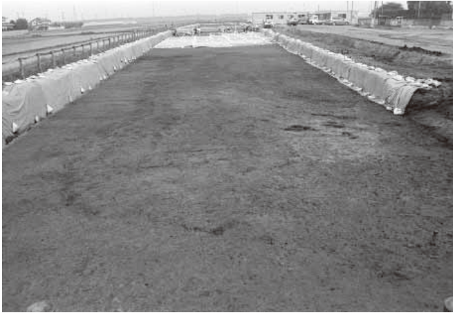
1. Ⅱ区古代～古墳時代遺構面遺構確認状況(南区/東から)
