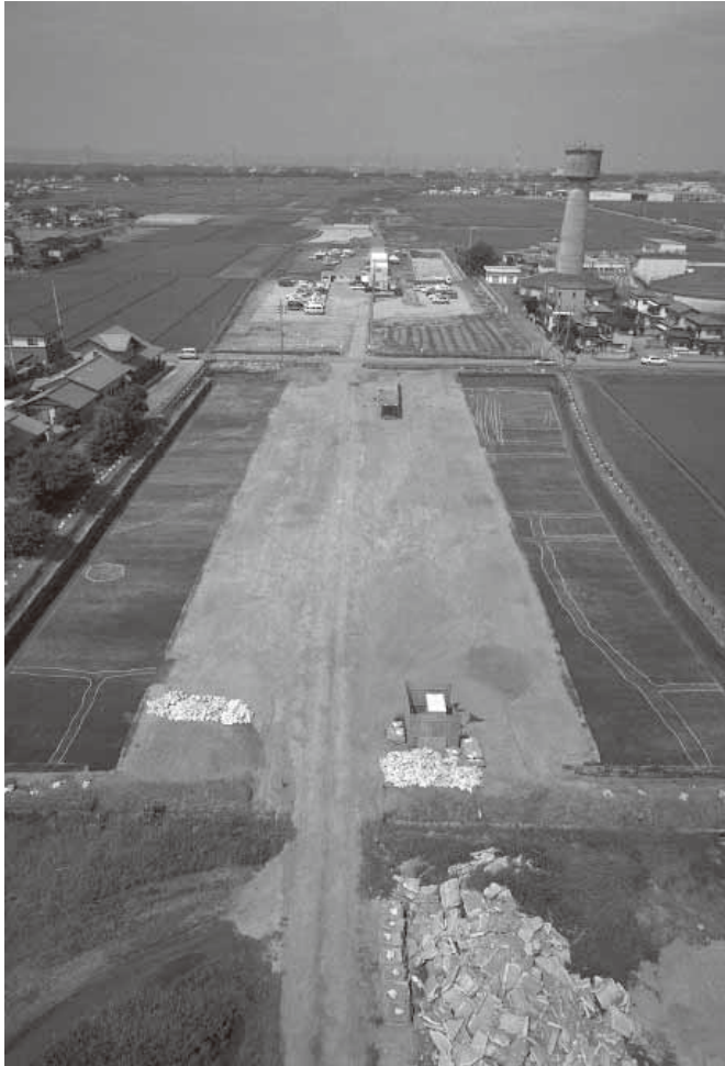
1. I区浅間Bテフラ直下水田全景(南・北区/東から)
