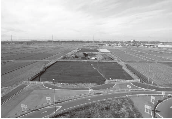
1. V区中近世面全景(西区/東から)
