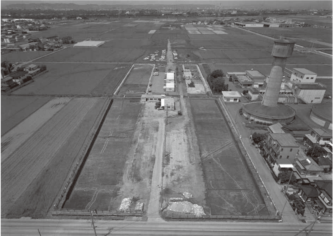
1. Ⅱ区中近世面全景(南・北区/東上空から)
