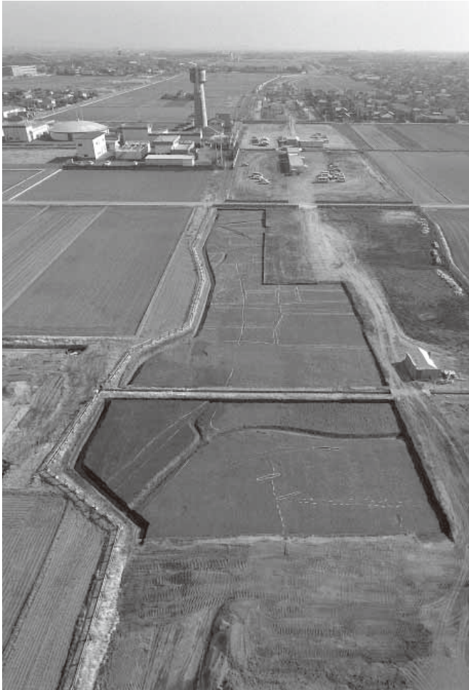
1. IV・V区中近世面全景(北区/西から)
