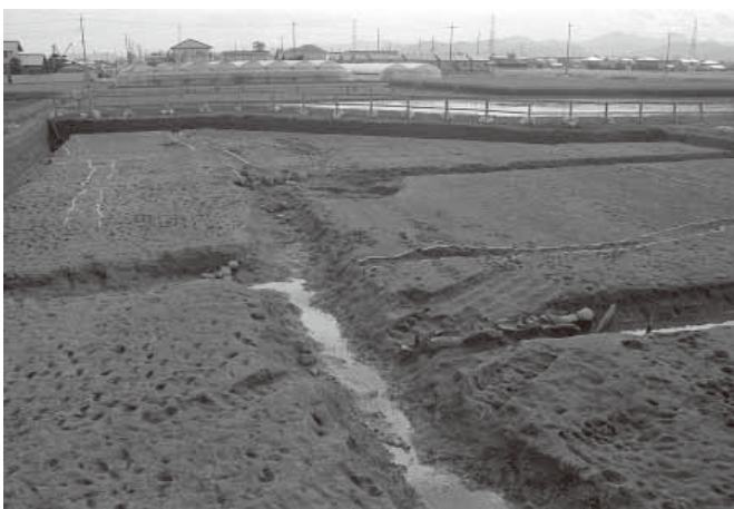
5. V区3号・5号・7号溝全景(北から)
