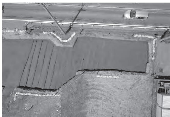
IV区復旧痕 全景 空撮
