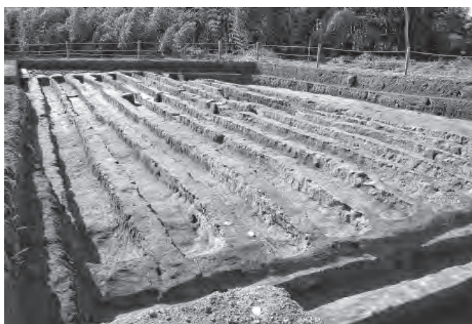
13号復旧痕 全景 北から
