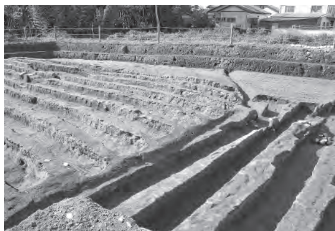
13・22号復旧痕 全景 北東から
