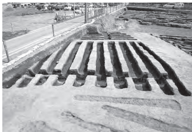
21号復旧痕 全景 北から
