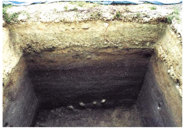
壁面 (試掘No.7)
