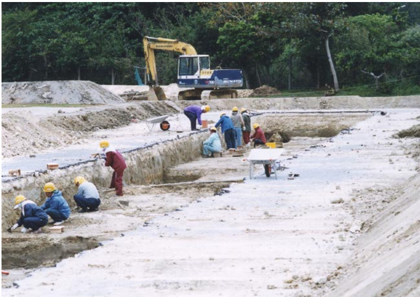
作業風景 (西側より)
