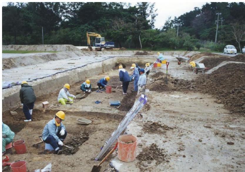
掘り下げ作業風景 (西側より)
