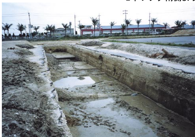
3 トレンチ東側より
