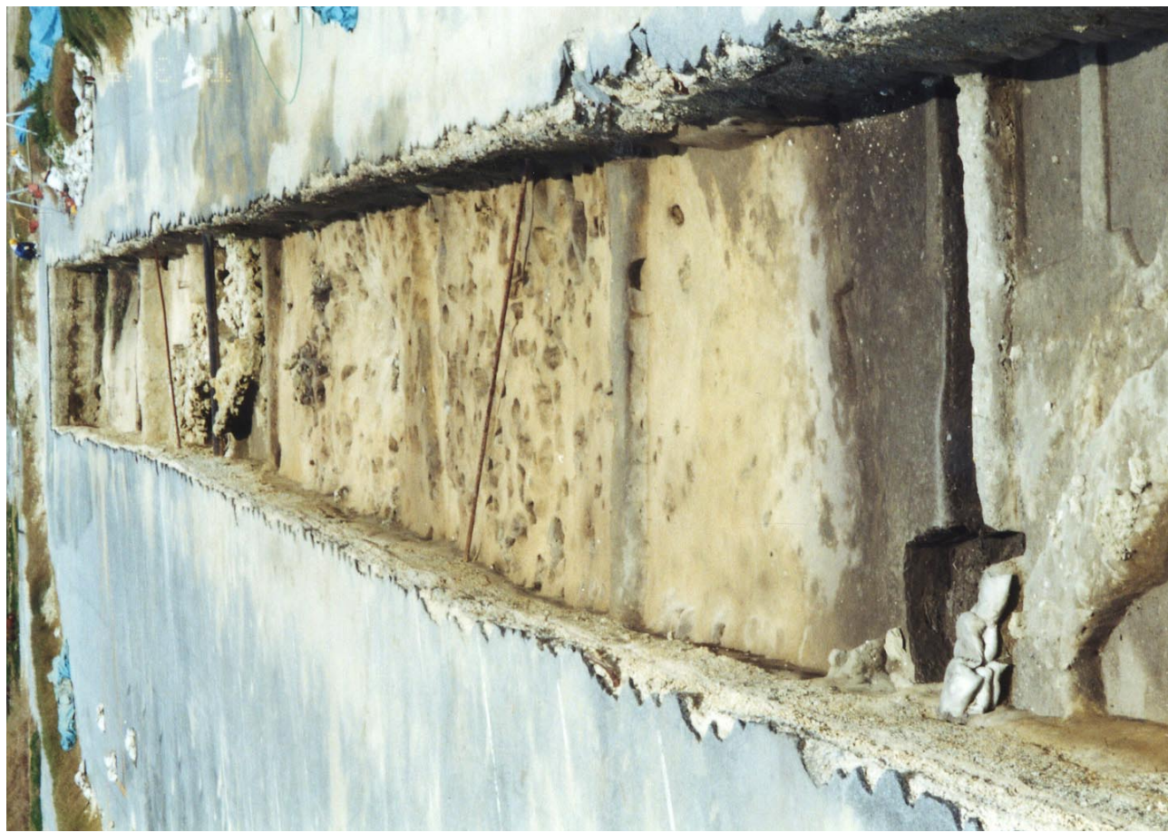
石列・柱穴群検出状況 (4-1～7)
