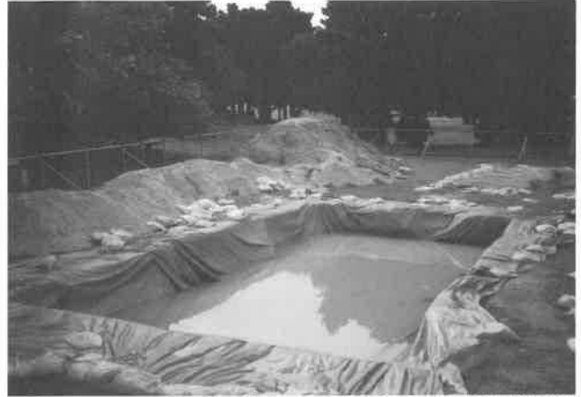
北トレンチ 雨による被害状況
