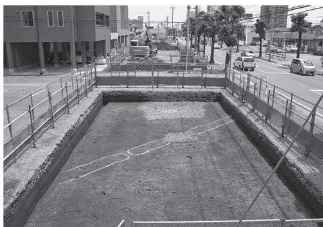
5区2面 (As-B下面) 全景 (西から)
