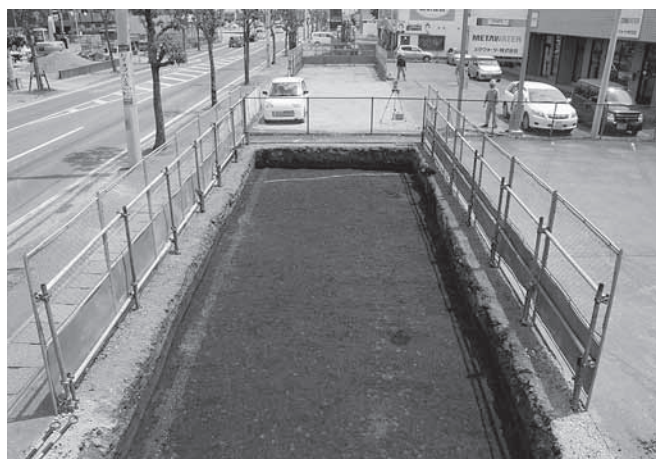
34区2面 (As-B・B混凝土層下面) 東半 全景 (西から)
