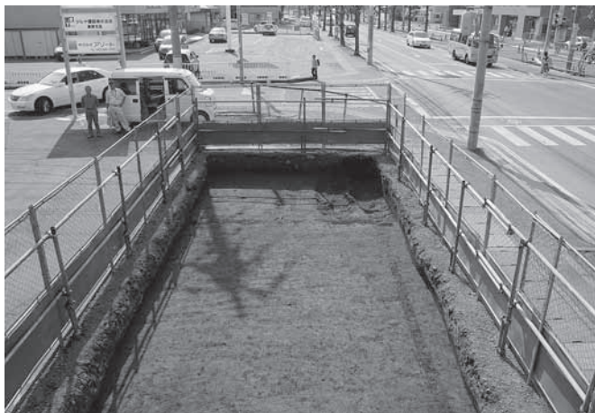
34区1面 (As-A混凝土層下面) 西半 全景 (東から)
