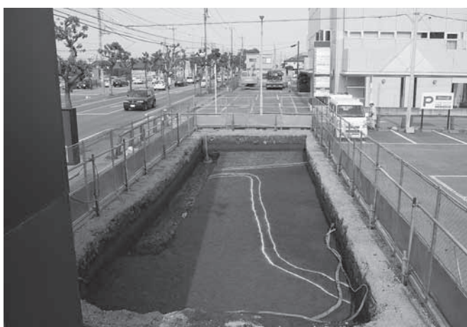
39区2面 (As-B下面) 全景 (西から)
