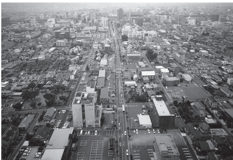
▲ 岩押Ⅲ遺跡遠景（高崎駅東口線 東方上空から望む）
