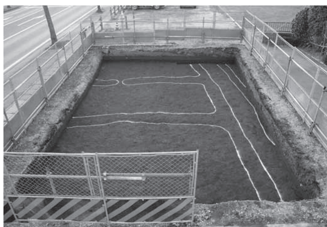
11区2面 (As-B下面) 全景 (東から)
