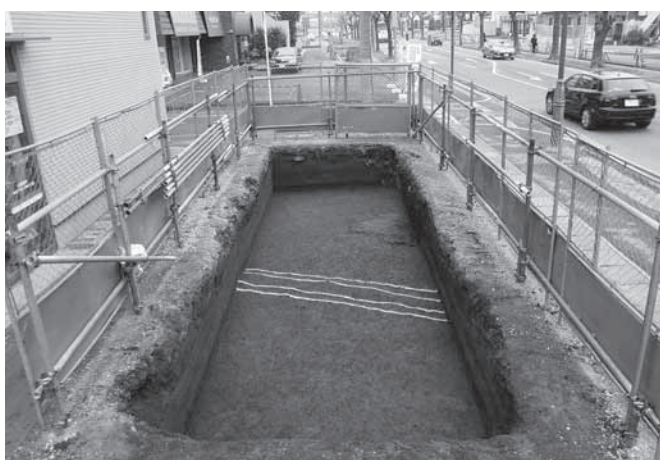
29区2面 (As-B下面) 全景 (東から)
