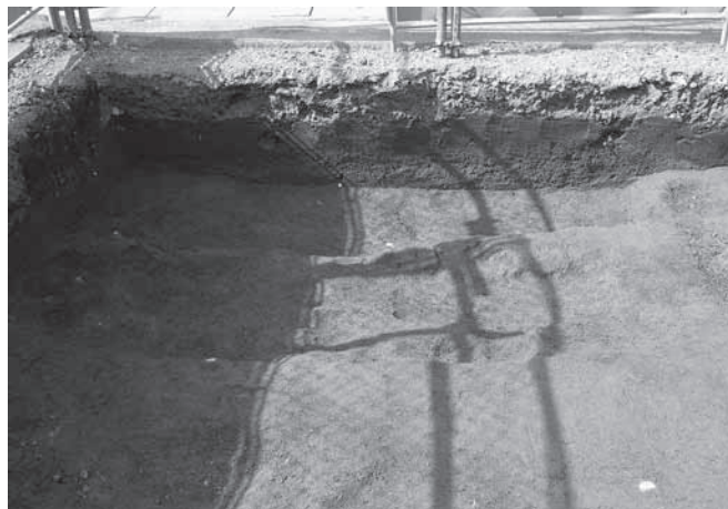
34区1面 (As-A混凝土層下面) 西半 復旧土坑 (南から)
