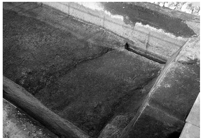
B区1号谷2面全景（南から）
