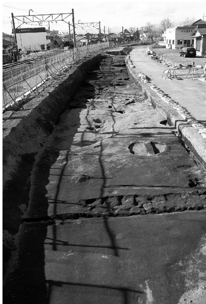
C区全景（東から）
