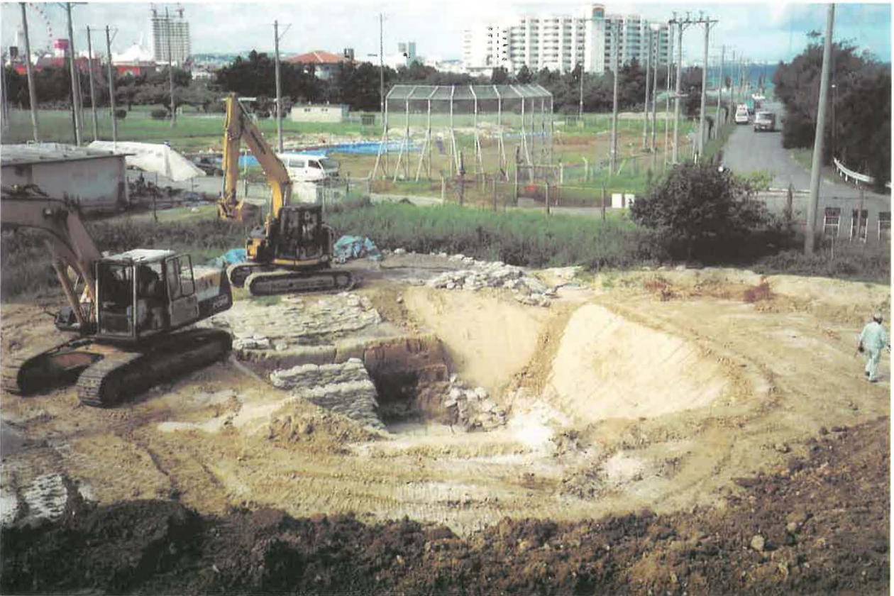
図版31：埋め戻しの状況
