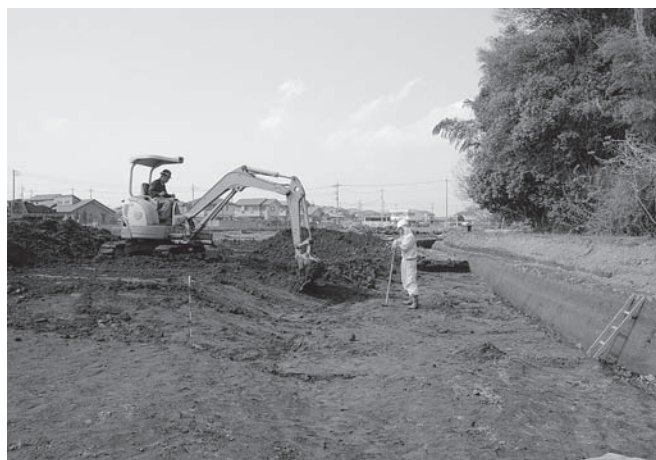
小型掘削重機による「上池」2号溝埋没土の除去 (南から)
