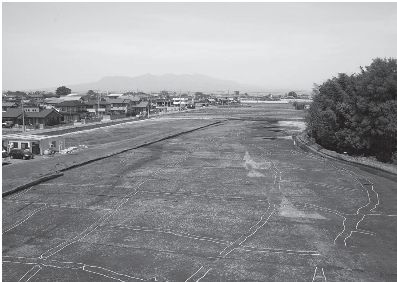
「上池」全景（南から）、画面奥が赤城山
