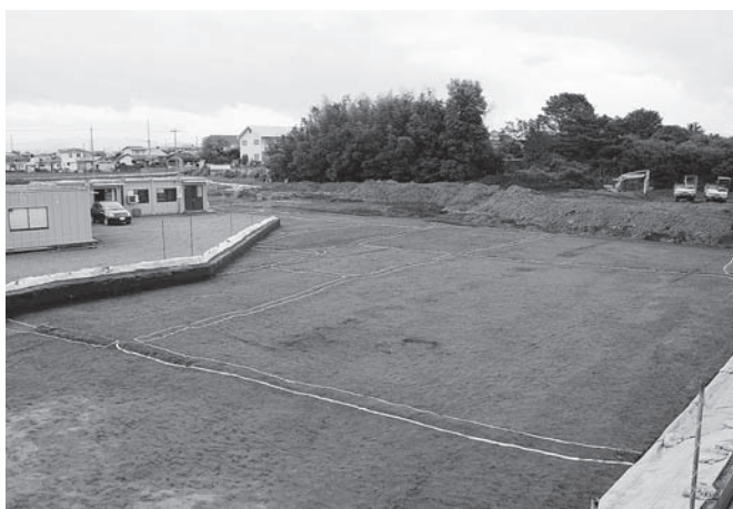
12区第2面全景（南西から）
