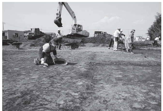
As-B下水田検出作業風景 (南から)
