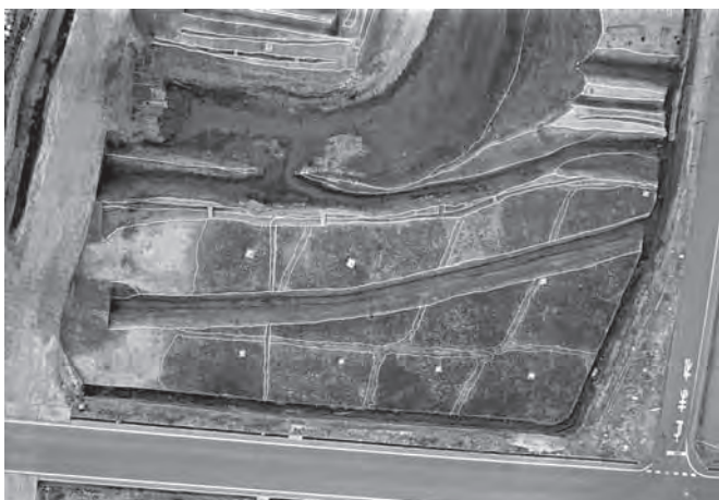
④ 1a区西側全景（上方が東）
