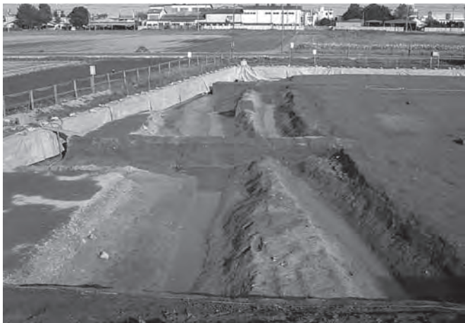
③ 2 a区15・18号溝（西から）
