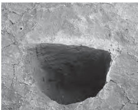
⑬ 13号掘立柱建物-7断面(南から)
