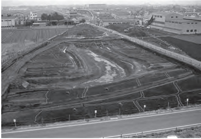
① 1区6面水田全景（西から）
