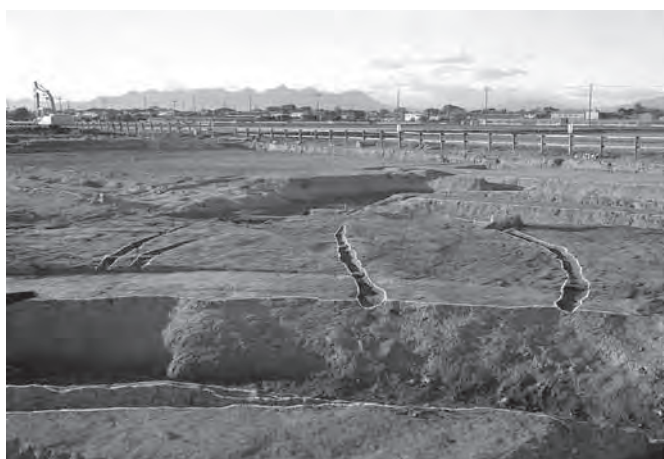
⑥ 2 b 区31～35号溝（南東から）
