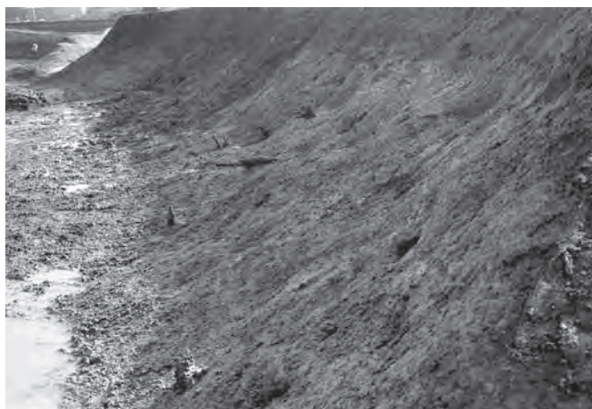
⑤ 大溝氾濫部分の杭（西から）
