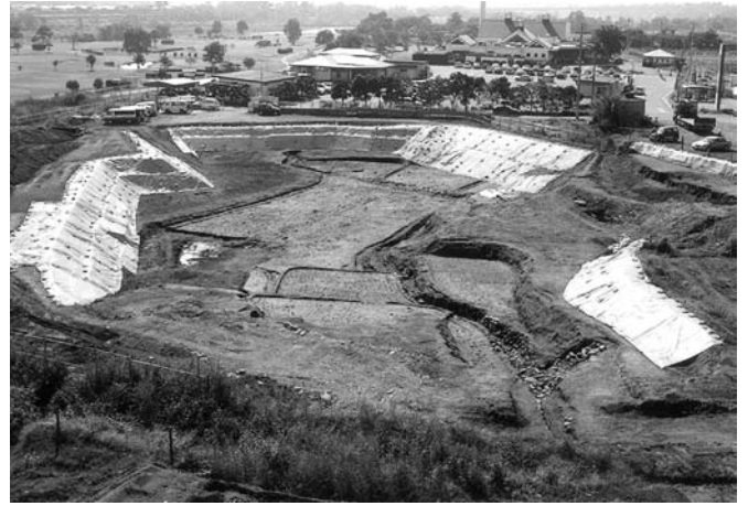
I区全景 北から
