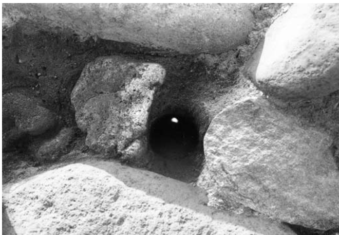
Ⅱ区7号水田取水口-1 東から
