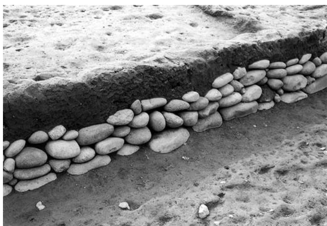
Ⅲ区石垣段差 東から
