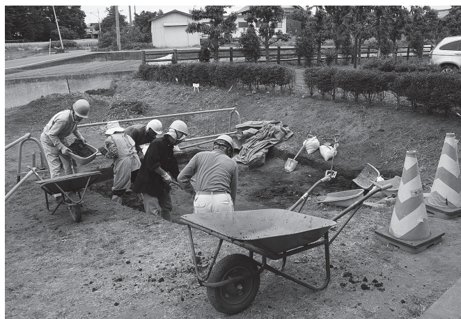
4区人力による掘削（南東から）
