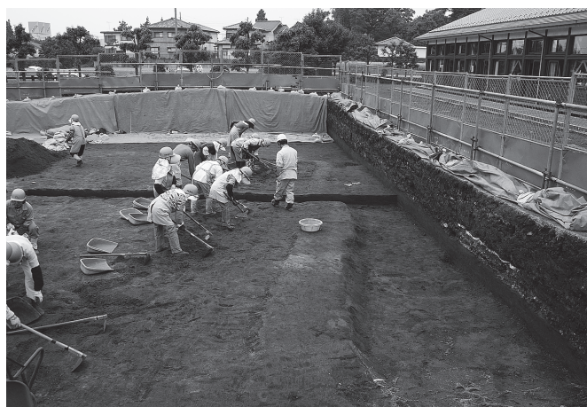
5-b区遺構確認作業（東から）
