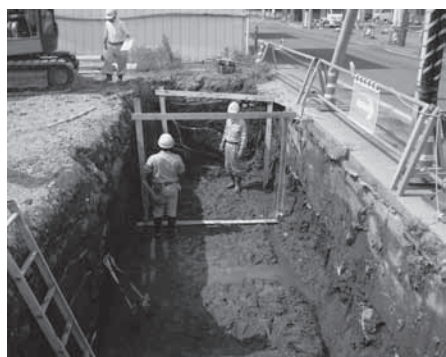
県文化財保護課試掘調査の様子 (南から)
