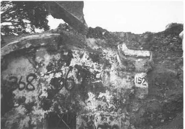
図版16 亀甲墓 (一段左) 漆喰除去後 (一段右) 石積解体作業状況
