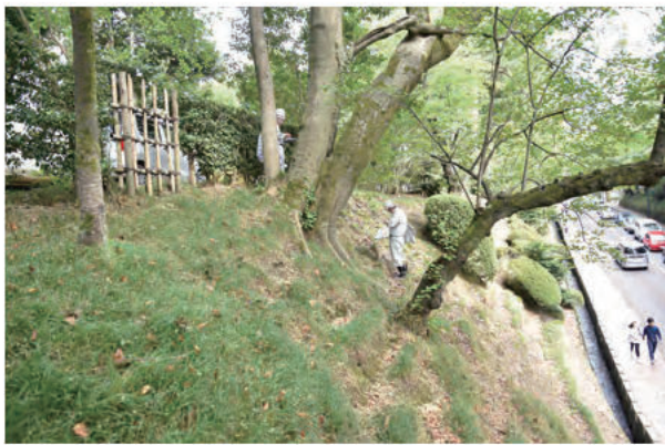
④川口門付近現況 南西から
