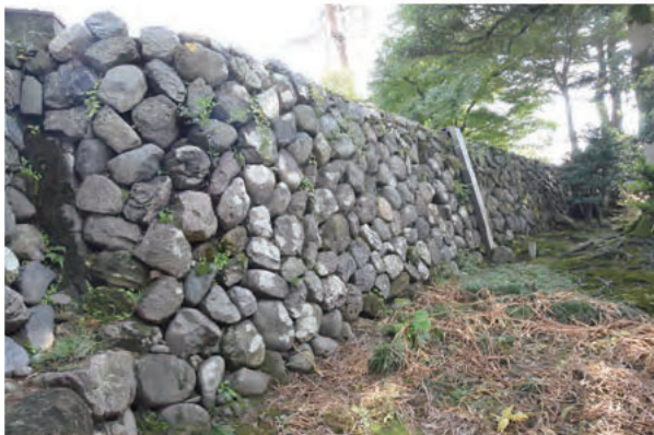
③水道石垣 北から
