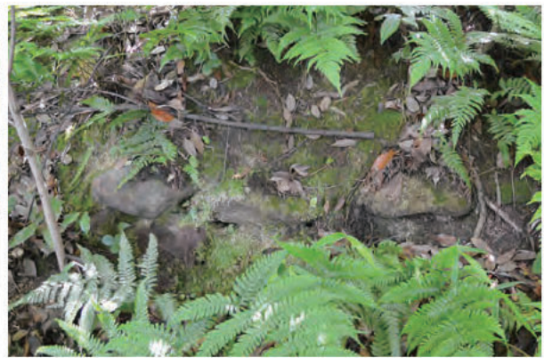
⑤高之亭西側塀基礎石積 西から
