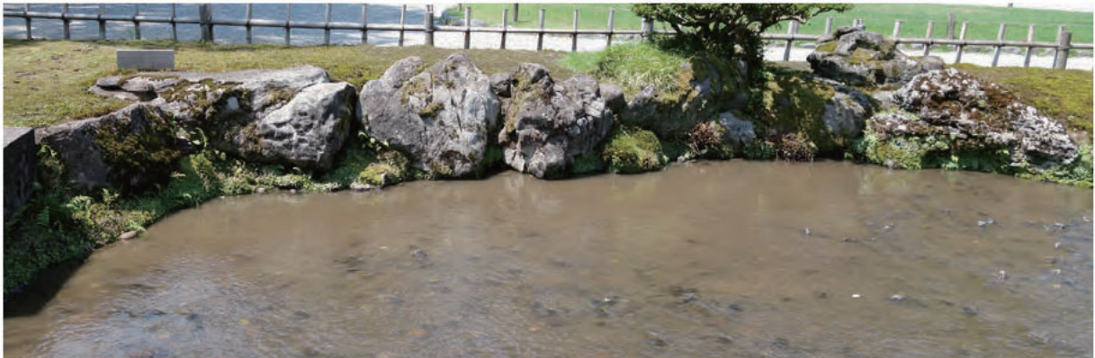
③曲水北西部 護岸 北東から
