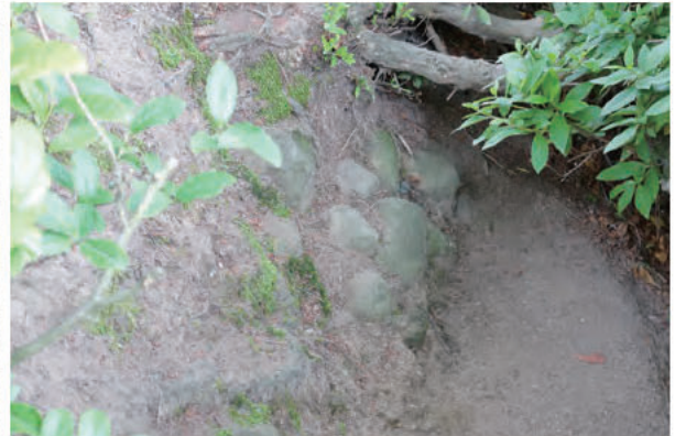
④西辺土塀下石積 北から
