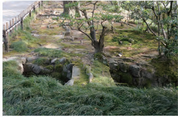
②西辺塀基礎（瓢池排水路上部） 北から
