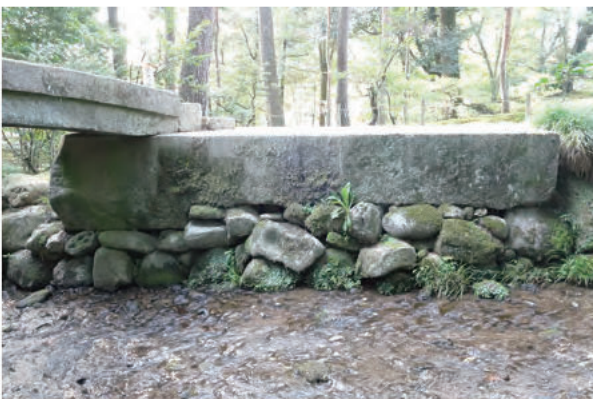
③黄門橋橋台石側面 東から
