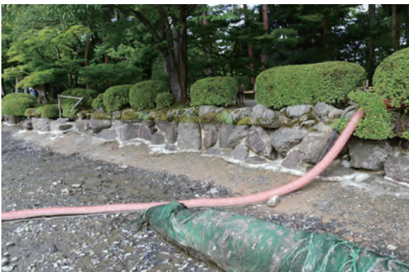
⑦霞ヶ池西～北岸 護岸石組 東から
