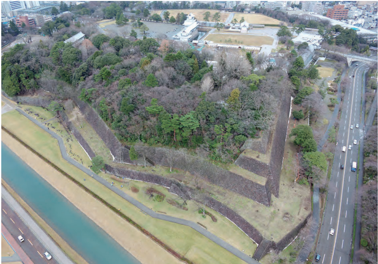
金沢城跡 東ノ丸等全景 南から
