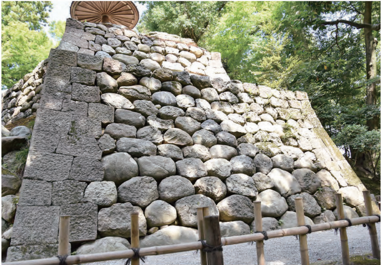
① 栄螺山石垣南西面（石垣1） 修復後
