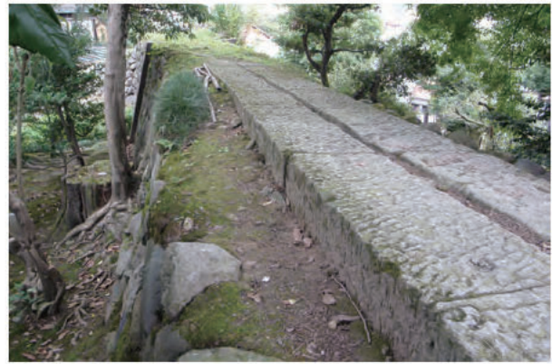
②水道（辰巳用水石管） 南から
