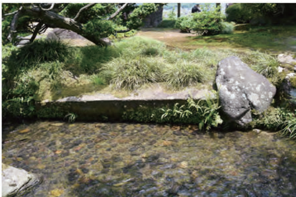
④曲水北西部 護岸（戸室切石） 南西から
