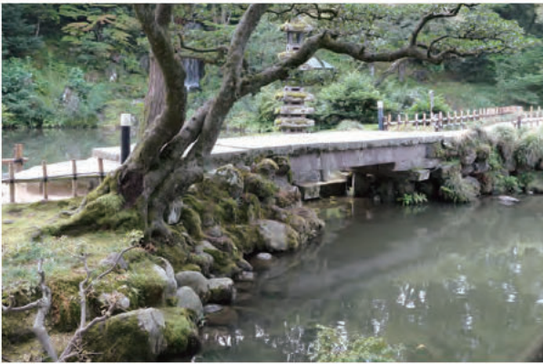
②日暮橋 全景 北西から
