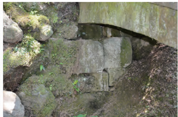
⑤黄門橋橋台石積 北西から
