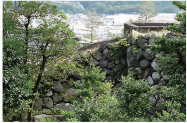
②水道屈曲部 南西から
