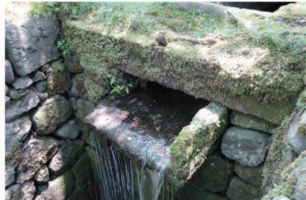
④西辺塀基礎（瓢池排水路上部） 南西から
