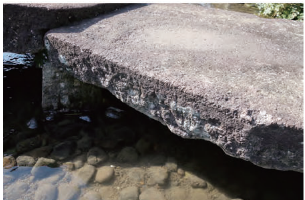
④雁行橋（亀甲橋）橋板側面 東から
