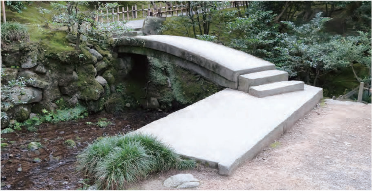
①黄門橋全景 北西から
