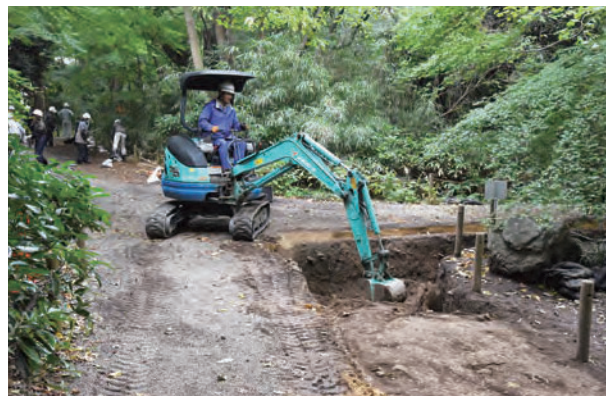
埋め戻し作業
