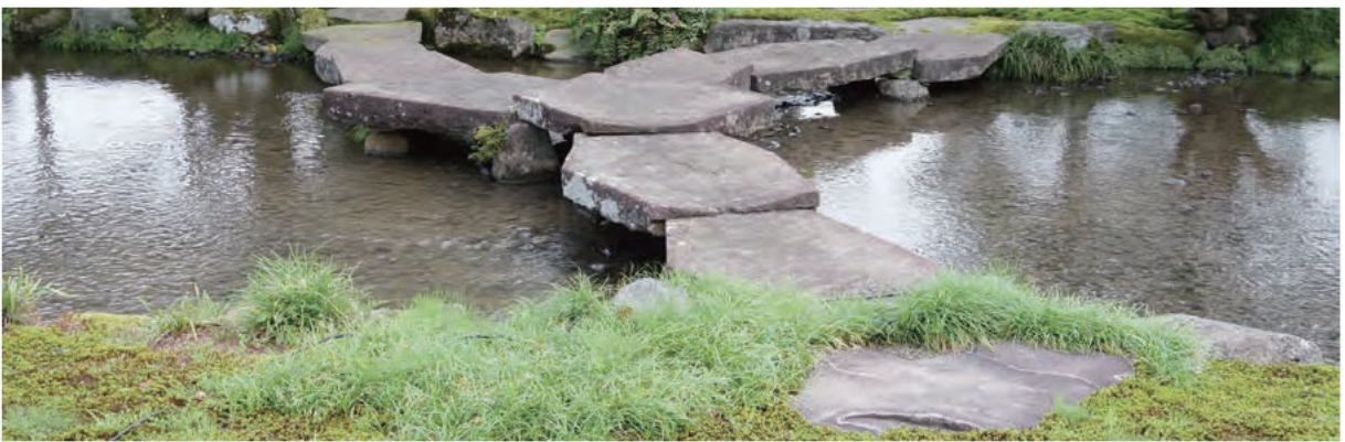
⑥雁行橋（亀甲橋） 全景 南西から
