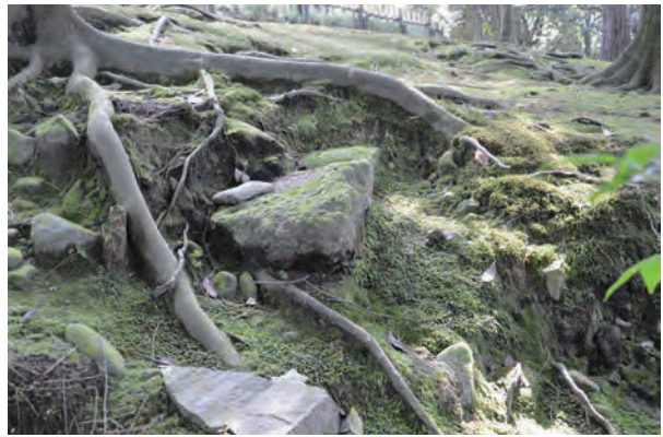
⑥西辺塀基礎 北から
