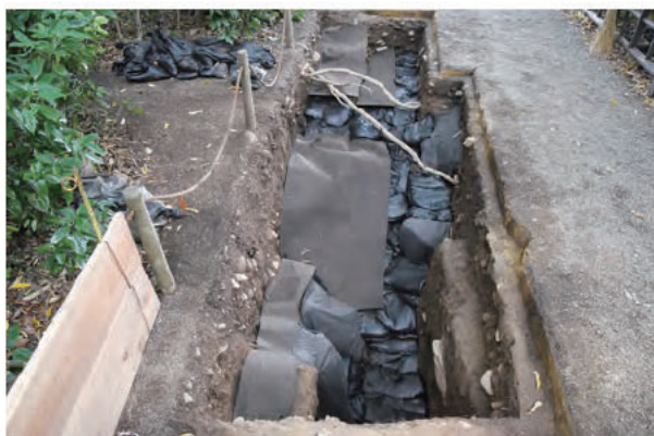
埋め戻し作業（遺構養生）
