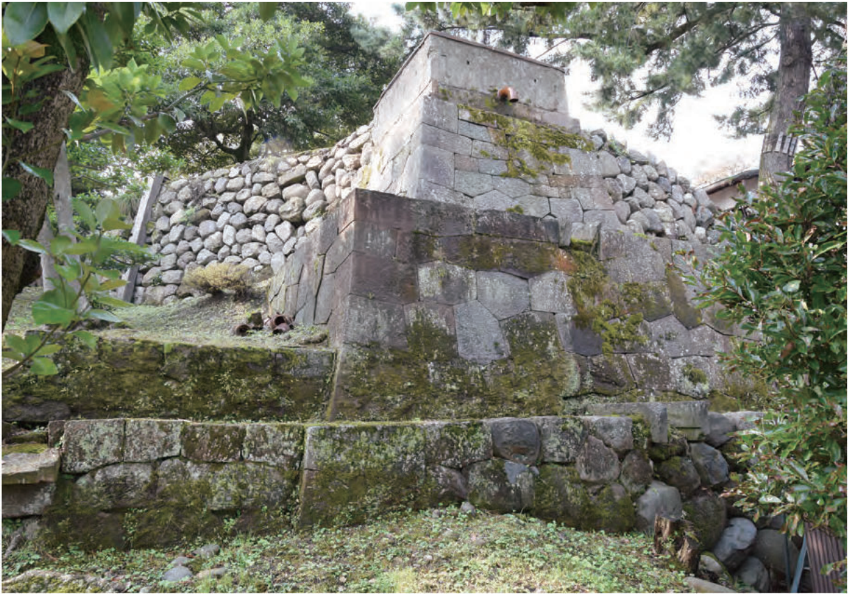
③水道石垣北面（樹下）
