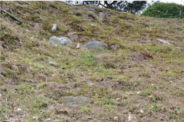
③北辺石垣上段 北東から
