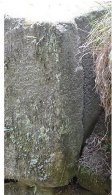
④黄門橋橋台石加工痕
