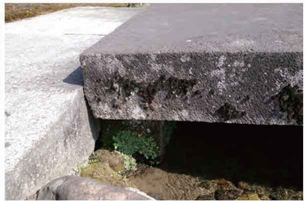
⑤雪見橋 橋板北西側面
