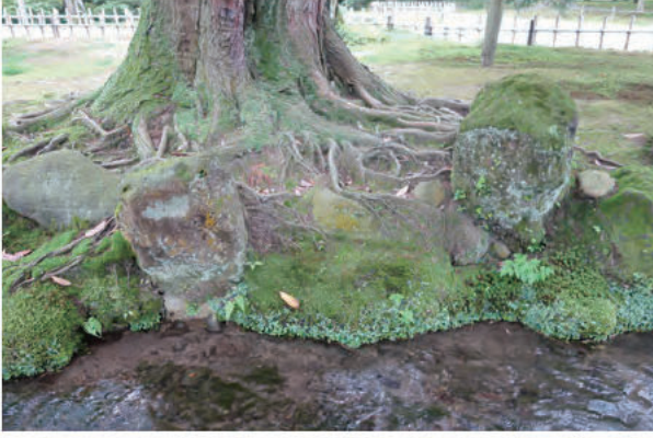
①曲水南東部 橋挟み石 北西から
