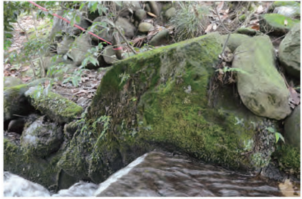
②翠滝上流護岸石北側 南から
