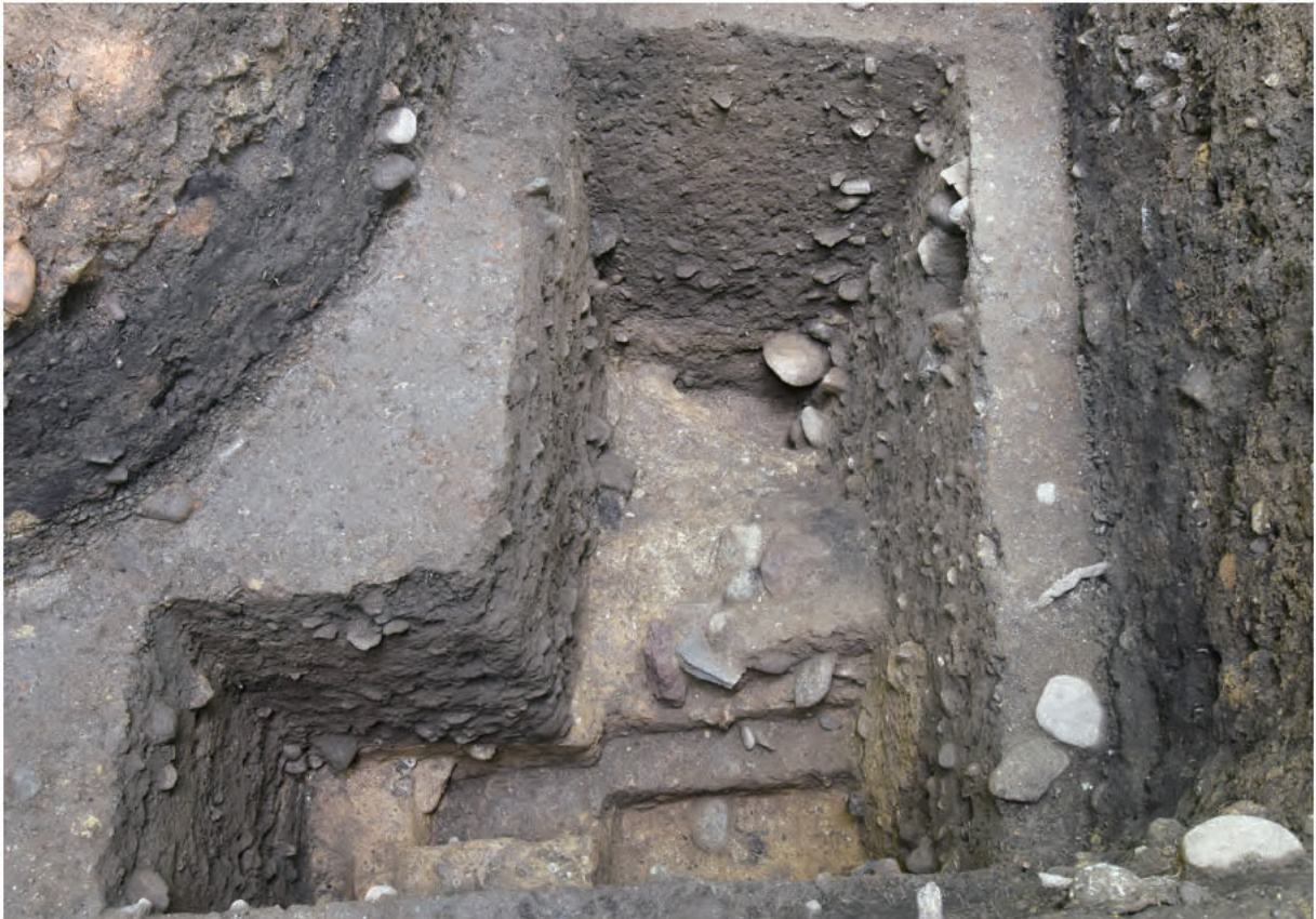
2014-1地点 ST3 Ⅲ層調査状況 西から
