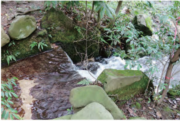
①翠滝上流護岸石 北から
