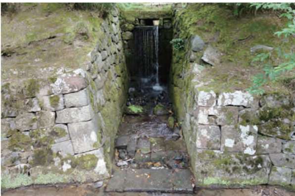
⑥瓢池排水路 西から
