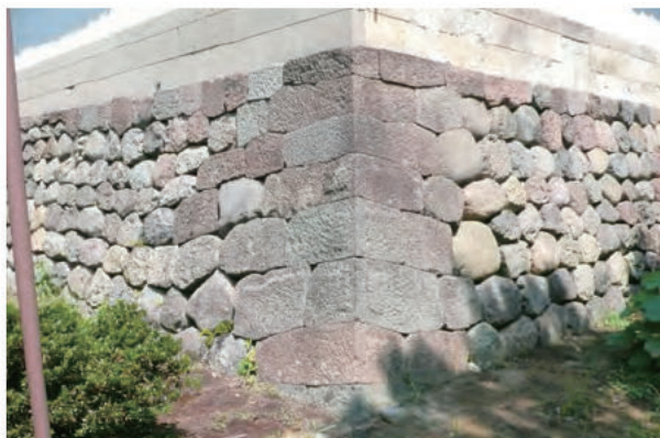
⑤巽御殿石垣 南西部出角
