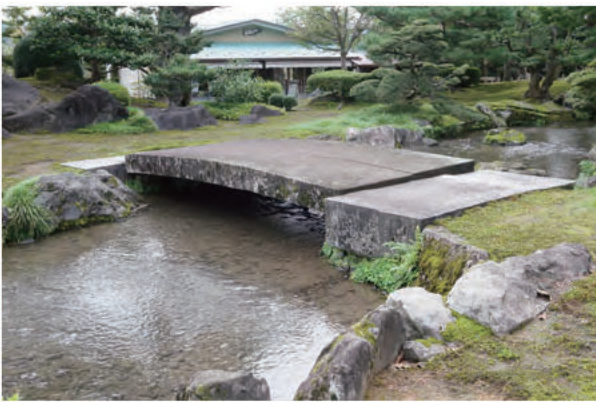
④雪見橋 全景 西から
