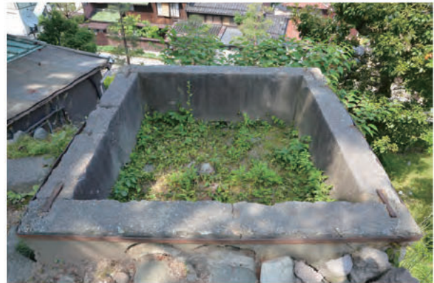
④水道屈曲部 樹（大樹） 南から
