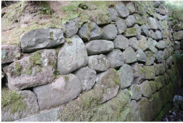
①瓢池排水路 石積 南西から
