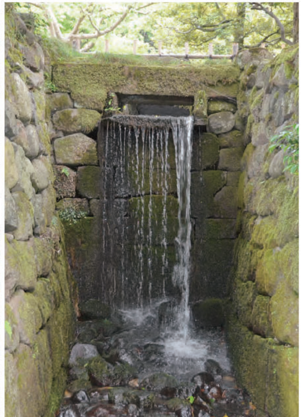
⑦瓢池排水路 滝状部 西から
