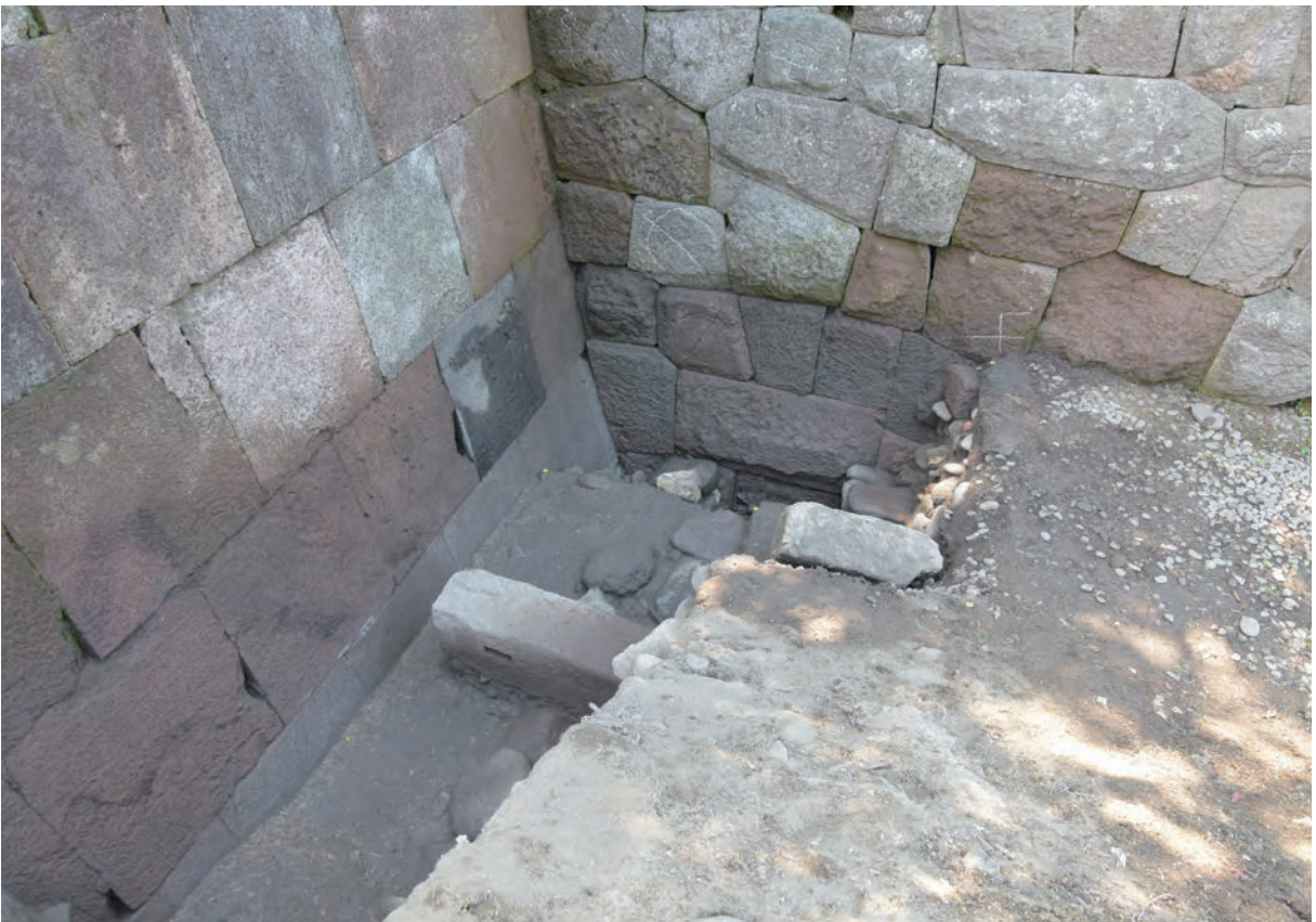
③ 同 確認調査基底部調査状況近景
