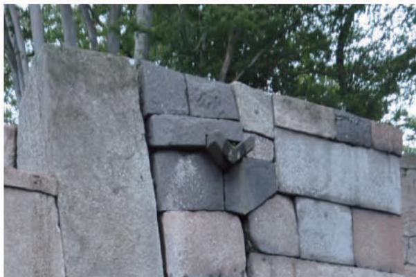
②石樋 (色紙短冊積石垣上部)
