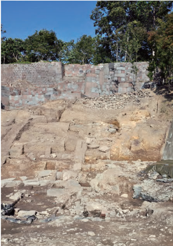
①導水路・滝石組（段落ちの滝） 全景 南西から
