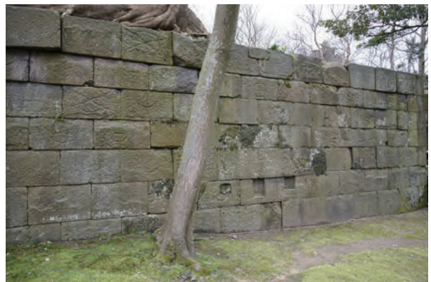
⑤ 数寄屋敷東石垣 (2720W) 南部 西から
