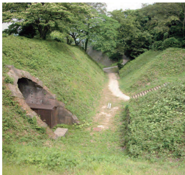
第17図 本丸北部の現況 西から
