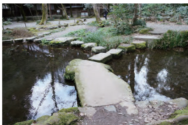
①琵琶島東端石橋 南西から
