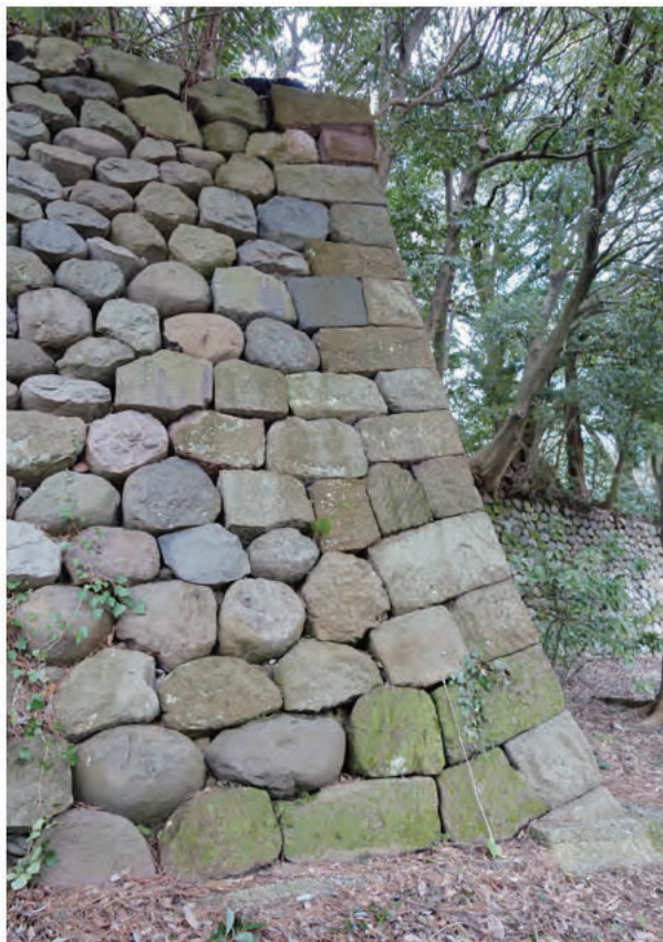
②石垣DE面間出角 南西から
