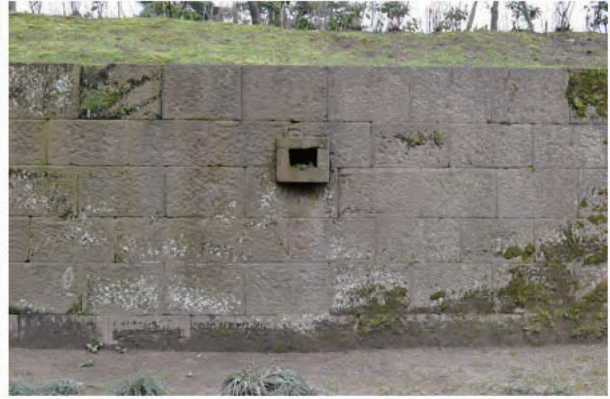
②数寄屋敷東石垣 石樋（中部） 西から
