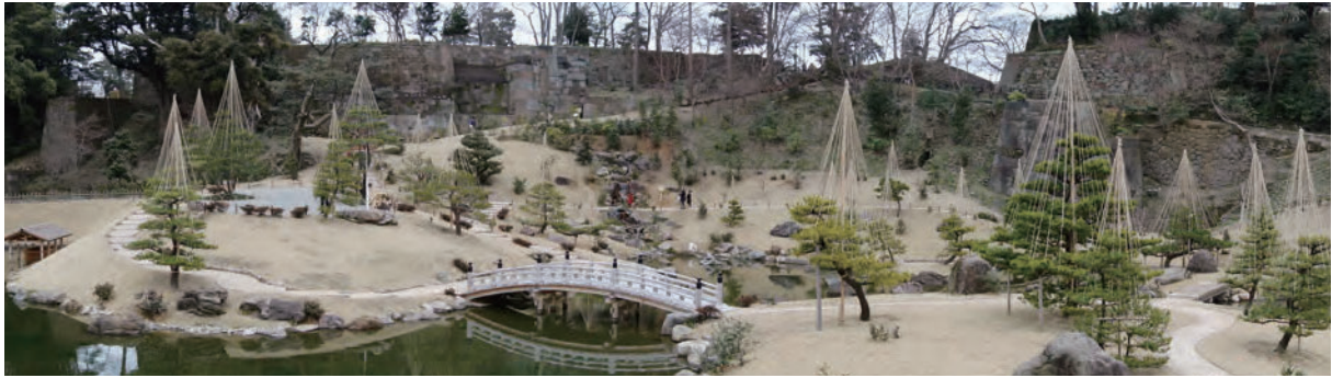
①玉泉院丸東側斜面の石垣 西から
