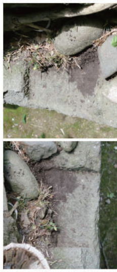
④現況(北から)
