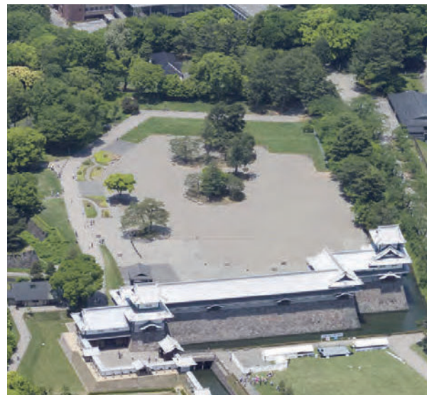
第 33 図 二ノ丸の現況 東から
