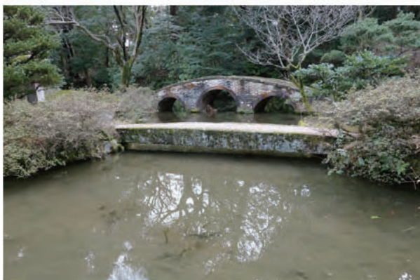
③琴瑟橋・図月橋 北西から
