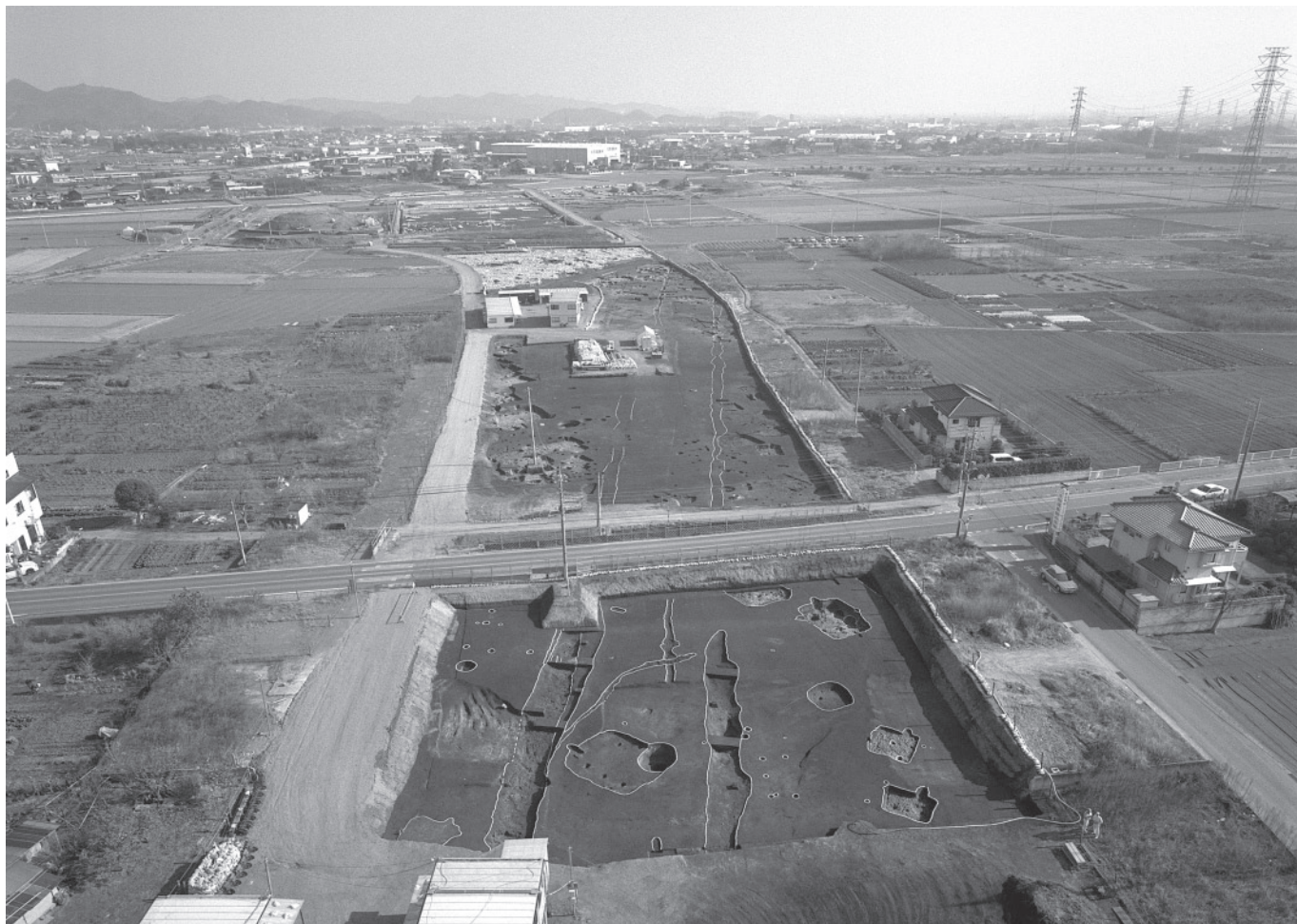
Ⅲ-2・Ⅳ区、大道東遺跡推定東山道駅路全景（西から）
