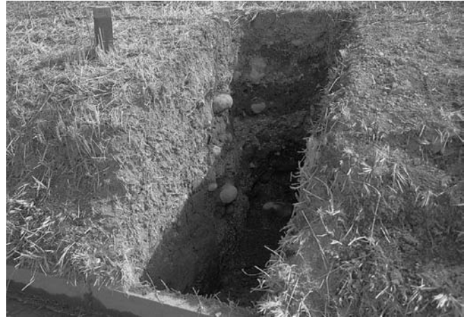
新田堀の築堤のトレンチ土層断面 (A-A') (北から)
