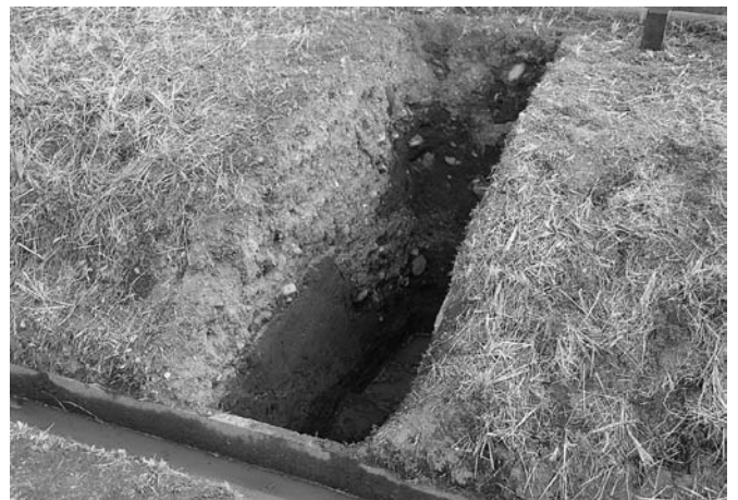
新田堀の築堤のトレンチ土層断面 (B-B') (北西から)
