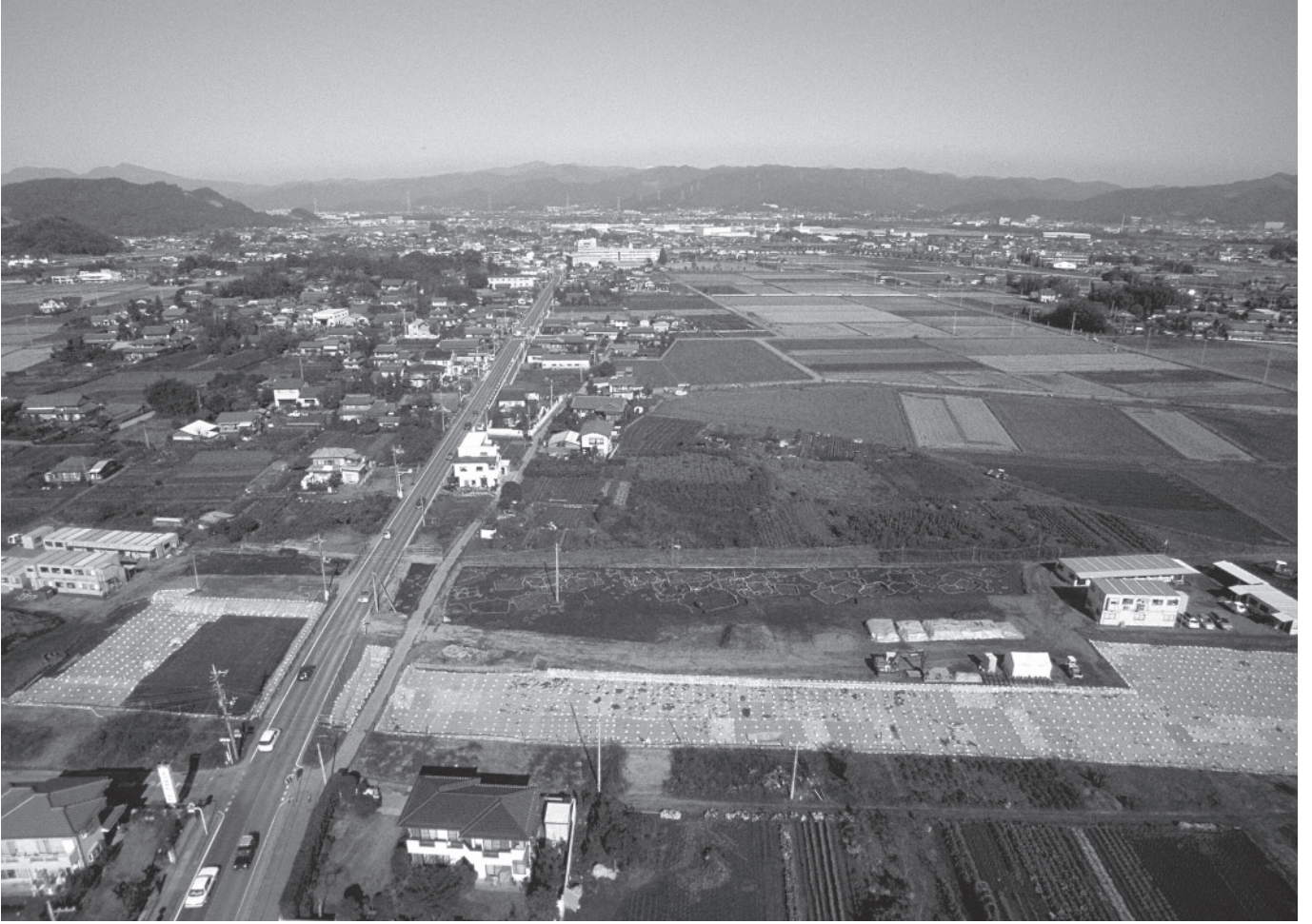
1・2区北部全景（南から）
