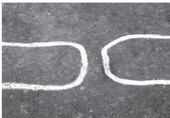
6区 水口近接（西から）
