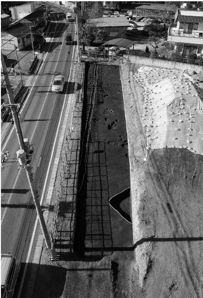
2. A区西側全景（東から）
