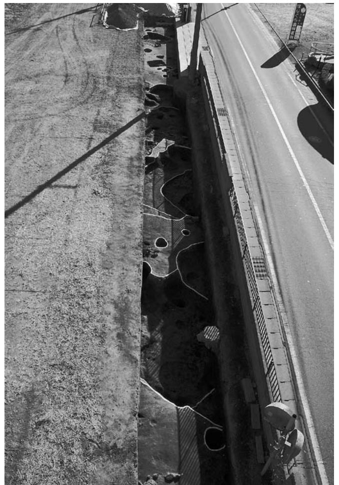
3. B区全景（西から）
