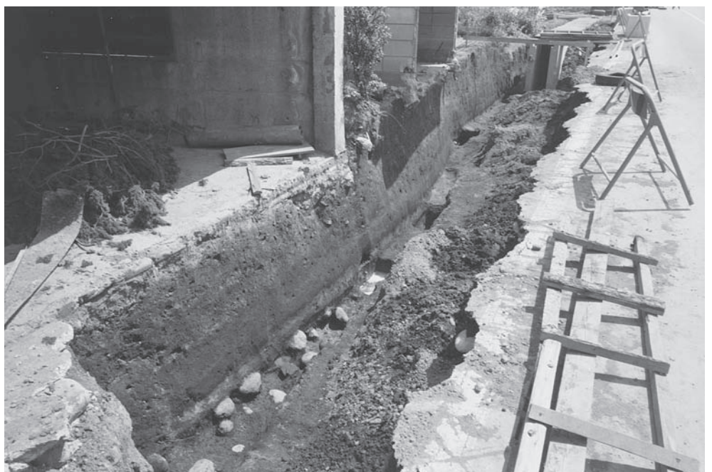
3 調査状況と土層断面一前方部 (南西から)
