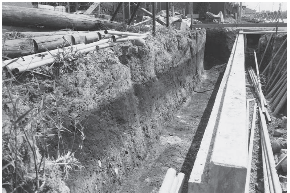
2 調査状況と土層断面一前方部 (西から)
