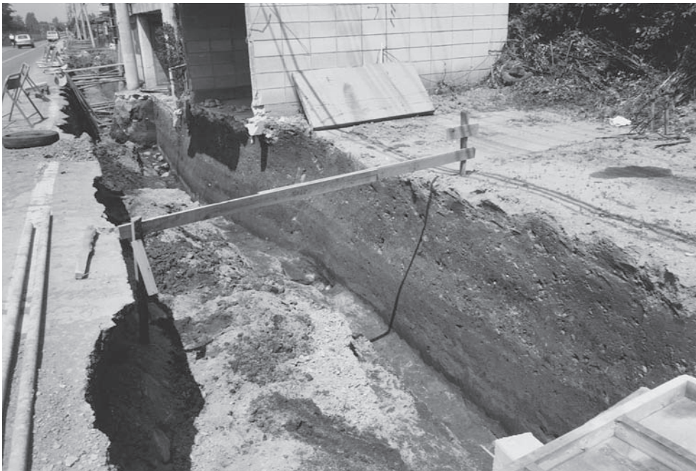
2 調査状況と土層断面－前方部 (南東から)
