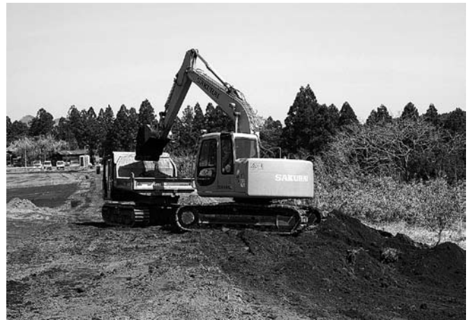
6. 埋め戻し作業
