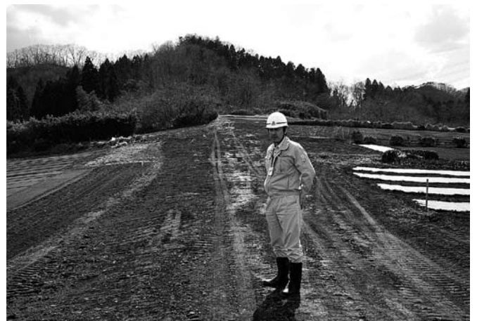
7. 埋め戻し完了状況
