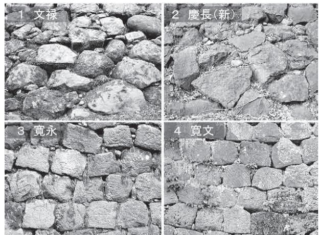
1～4の写真は、金沢城石垣の時代的変遷をわかりやすく示した四つの画面です。文禄・慶長・寛永・寛文とちょうど石垣技術が発展した最初の60年間の石垣の変遷を示しています。自然の石を積み上げた文禄の石垣から、規格化された石材が横目地を通して並ぶという形へと発展していく様子が金沢城内でよく見られます。
