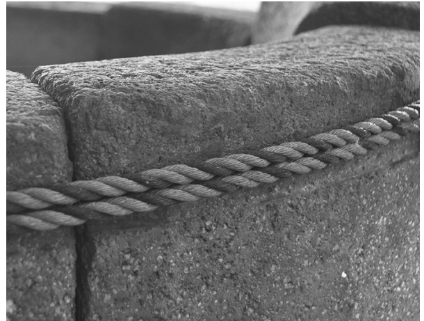
2 井戸枠上部 幅7.5cmの範囲を1cm程削り込む
