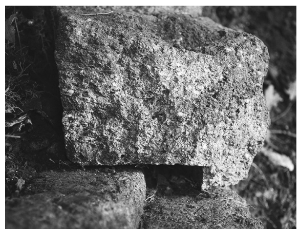
7 ④上・下段の組み合わせ加工 削り込んで、内・外部に段を作り出す ③も同様の加工
