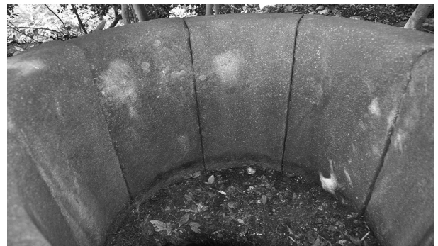
6 井戸枠内面 板石の形状は下部が狭い台形を呈する
