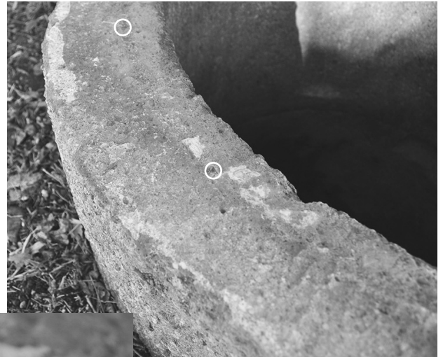
2 井戸側上面（部分） 近代以降、石製井戸側の上部にコンクリート製枠が設置される（現在撤去） コンクリート製枠を固定するための角釘及びその痕跡を約10箇所、その外部に枠当り痕を確認
